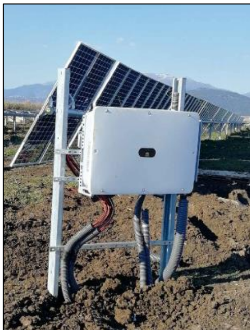
Figura 7 – Installazione dell’inverter in un impianto fotovoltaico esistente
