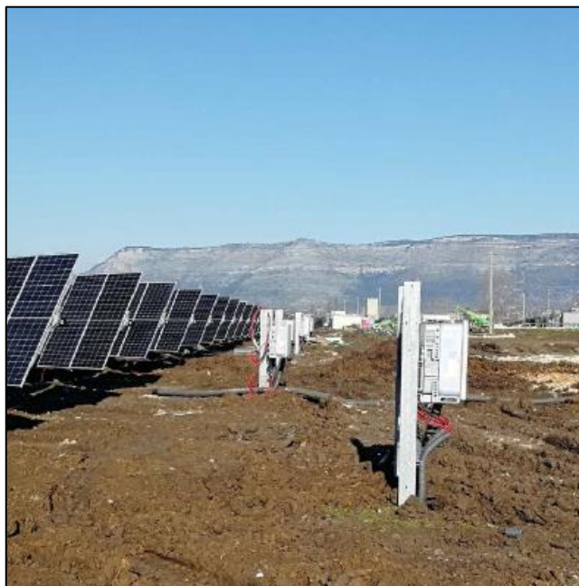
Figura 7 – Installazione dell’inverter in un impianto fotovoltaico esistente
