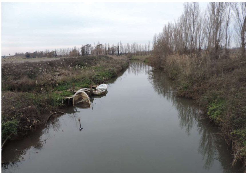
Fig. 15 – Panoramica degli argini del fiume Astura
