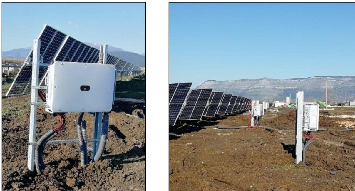
Figura 7 – Installazione dell’inverter in un impianto fotovoltaico esistente
