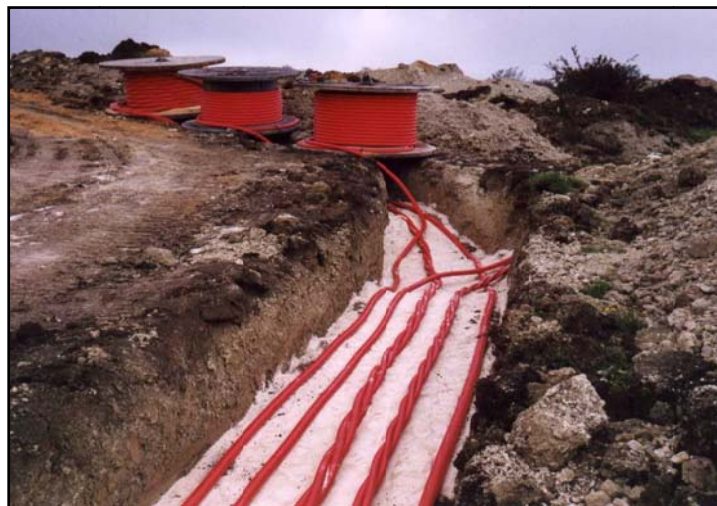
Particolare posa cavi elettrici.
