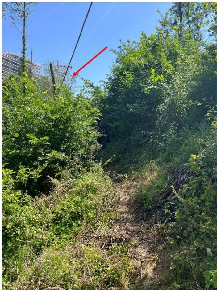
Figura 18: Dettaglio di un palo della rete elettrica inclinato, indicato dalla freccia rossa, nell'area della frana a N dell'area di progetto
