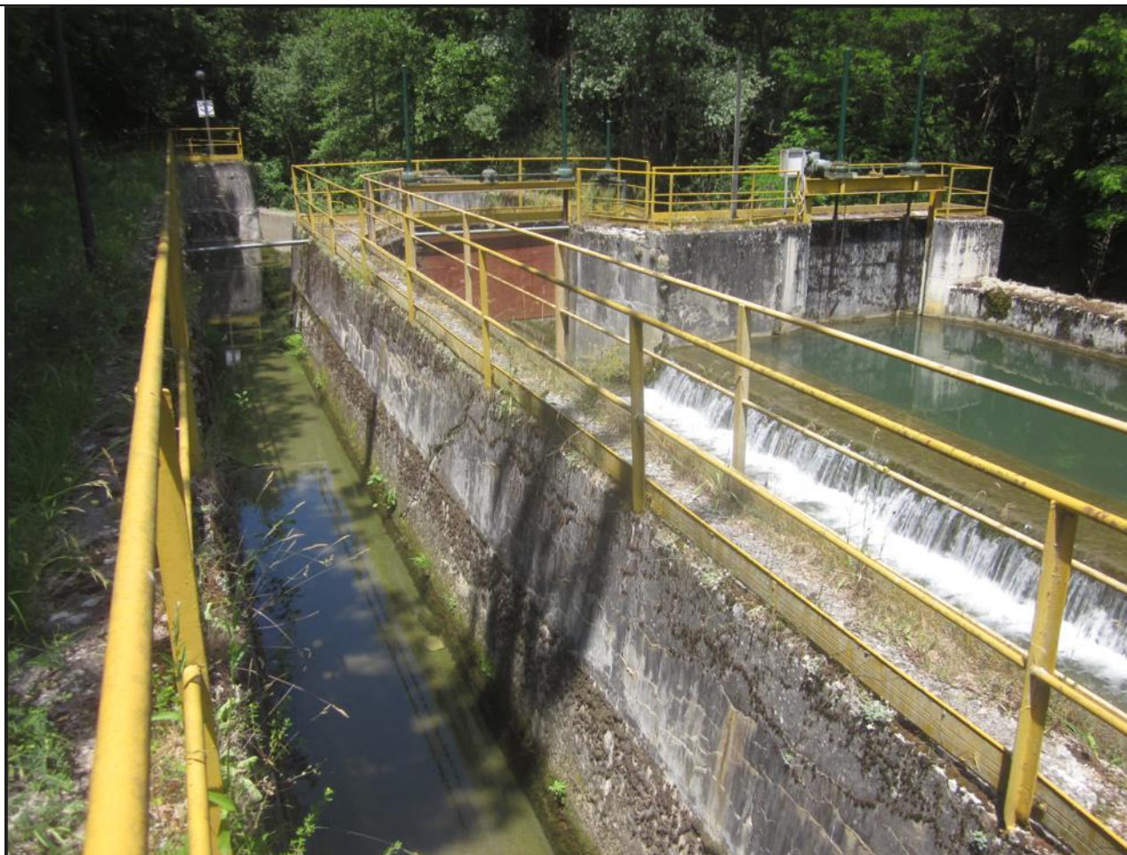
Figura 18 – Opera di presa lungo il corso del Torrente Castellano di Amatrice
