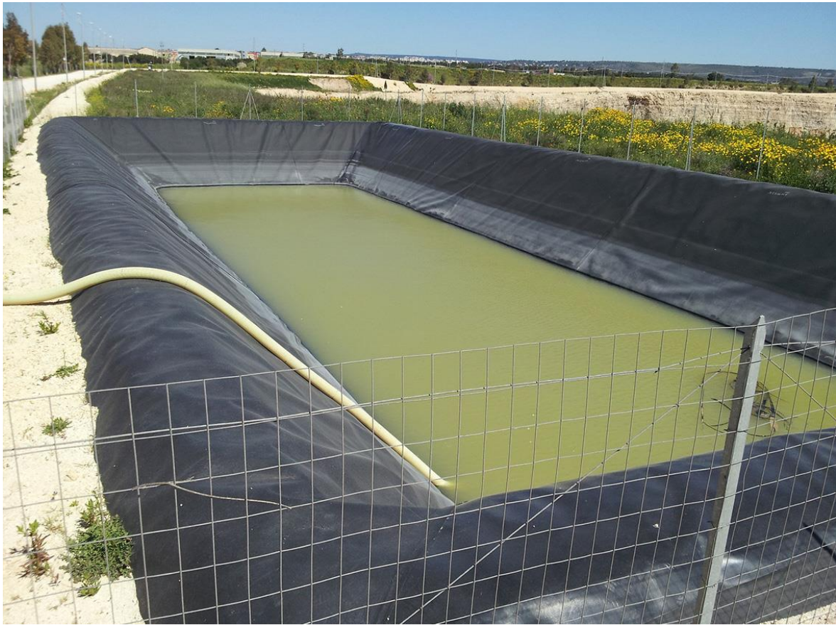
Figura 19 – Esempio di vasca raccolta acque piovane.
