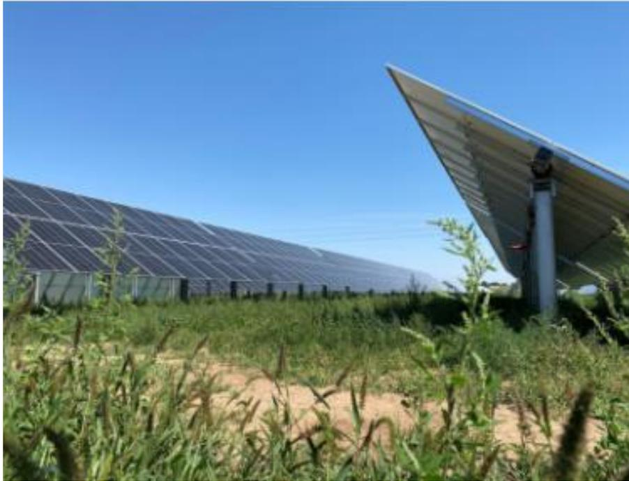
L'utilizzo di tali strutture permette di orientare i moduli fotovoltaici favorevolmente rispetto ai raggi solari nel corso della giornata, mantenendo invariata l'inclinazione dell'asse di rotazione del pannello rispetto al terreno, ovvero mantenendo invariato l'angolo di TILT.
