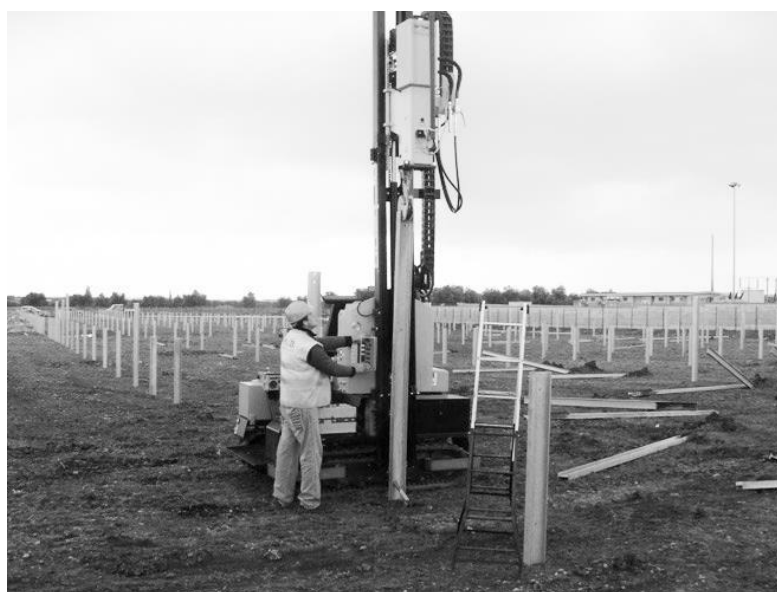
Figura 17 – Infissione con macchina battipalo
