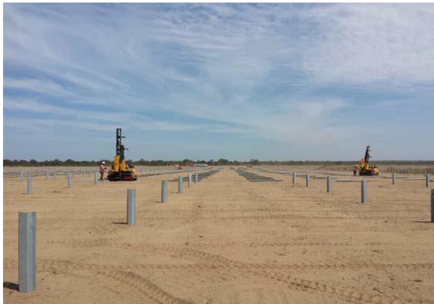
Figura 16 – Posa in opera profili di palificazione
