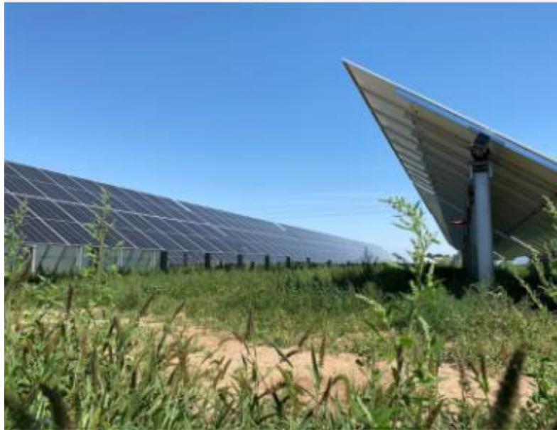
Figura 5-2 Tipico tracker fotovoltaico in configurazione "2-Portrait"
