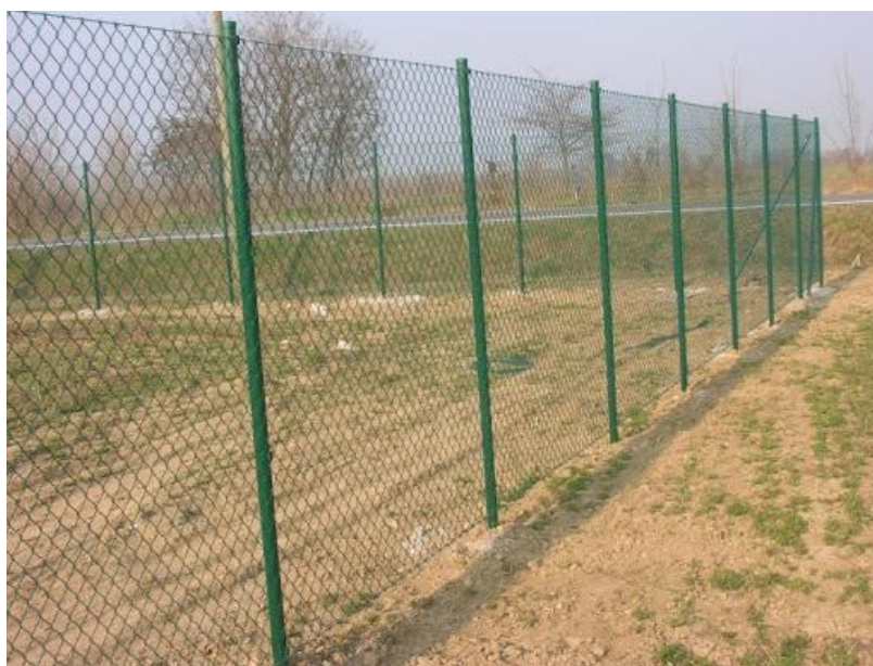
Figura 5-14 Tipologico recinzione perimetrale
