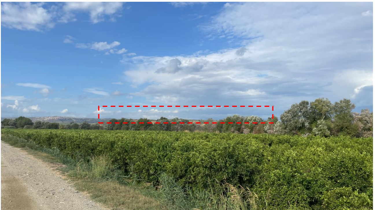
P18 - STATO POST OPERAM - Da questo punto di scatto l'impianto risulta visibile: grazie alla presenza di vegetazione la presenza dell'impianto risulta parzialmente mitigato
