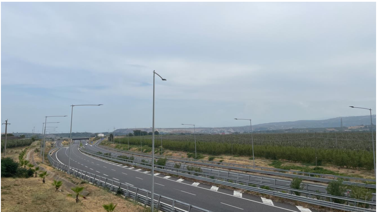
P28 - STATO POST OPERAM - L'impianto risulta in parte visibile
