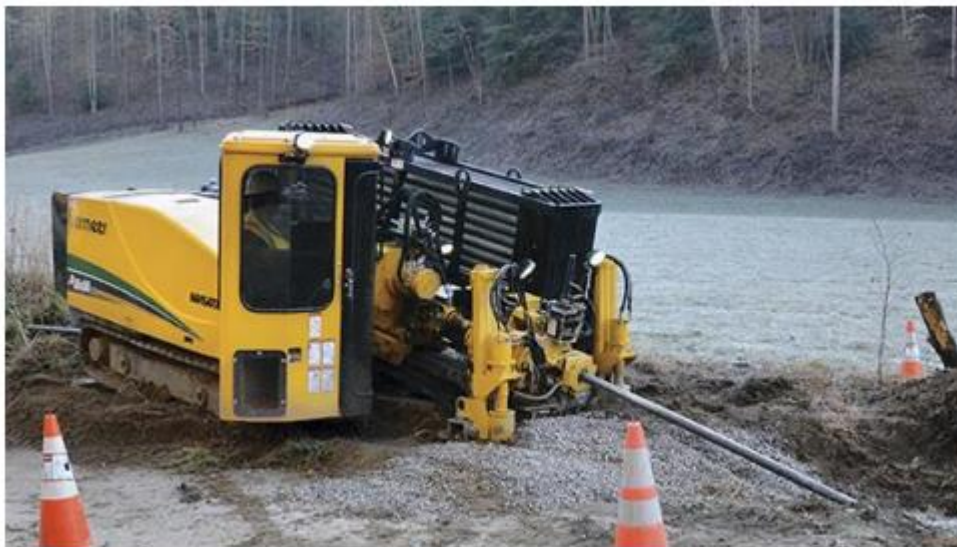
Figura 31: Scheda delle fasi operative per la realizzazione di tubazione a mezzo TOC
