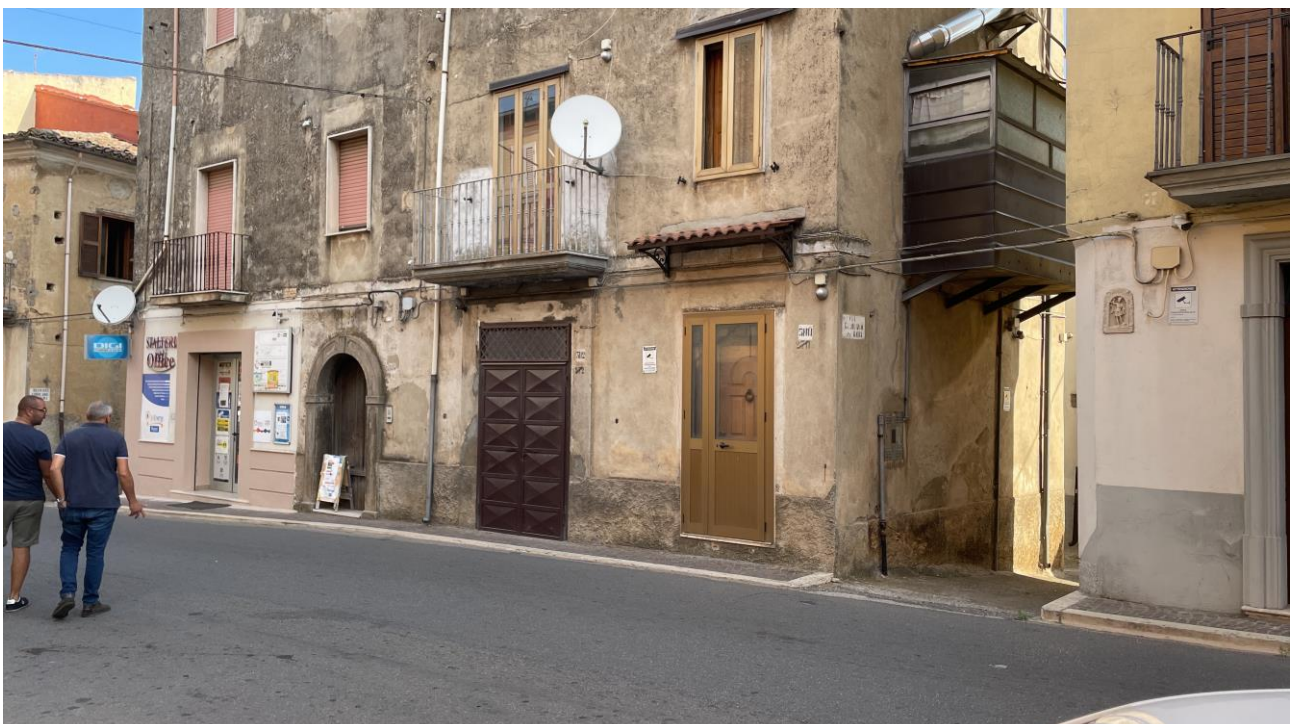
P8- STATO ANTE/POST OPERAM - NON VISIBILE Foto scattata da Palazzo Lucchetti - Centro Storico di Spezzano Albanese
