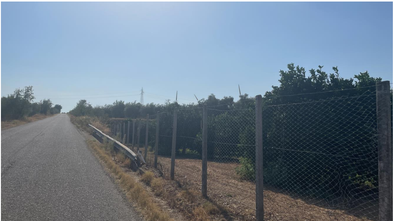
P19 - STATO POST OPERAM - L'impianto risulta parzialmente visibile
