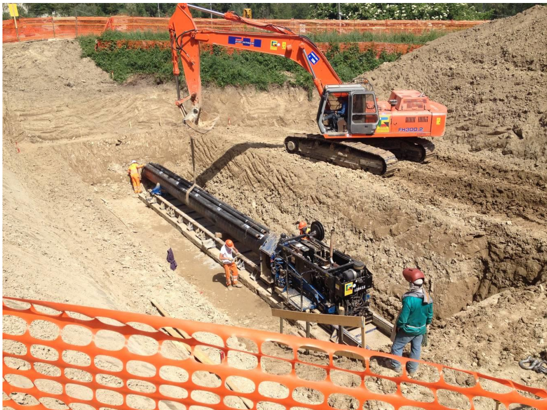
Fig. 2-12 - Trivella spingitubo.
