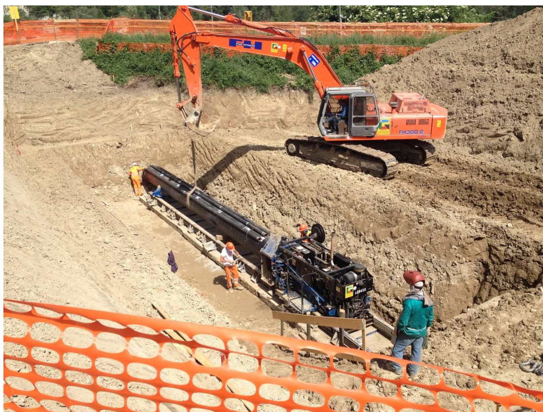
Figura 3-4 - Trivella spingitubo
