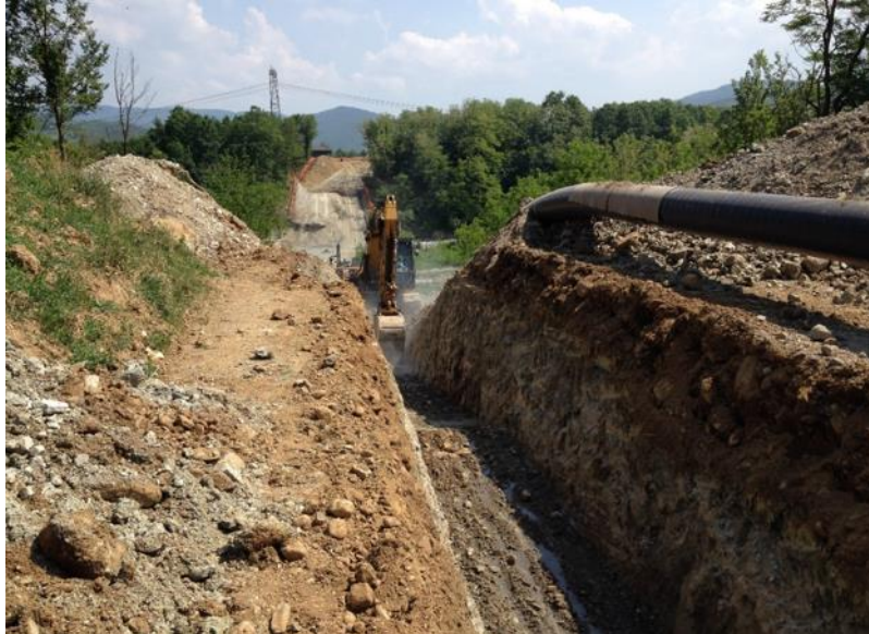
Figura 3-3– Scavo per l'alloggiamento della condotta.
