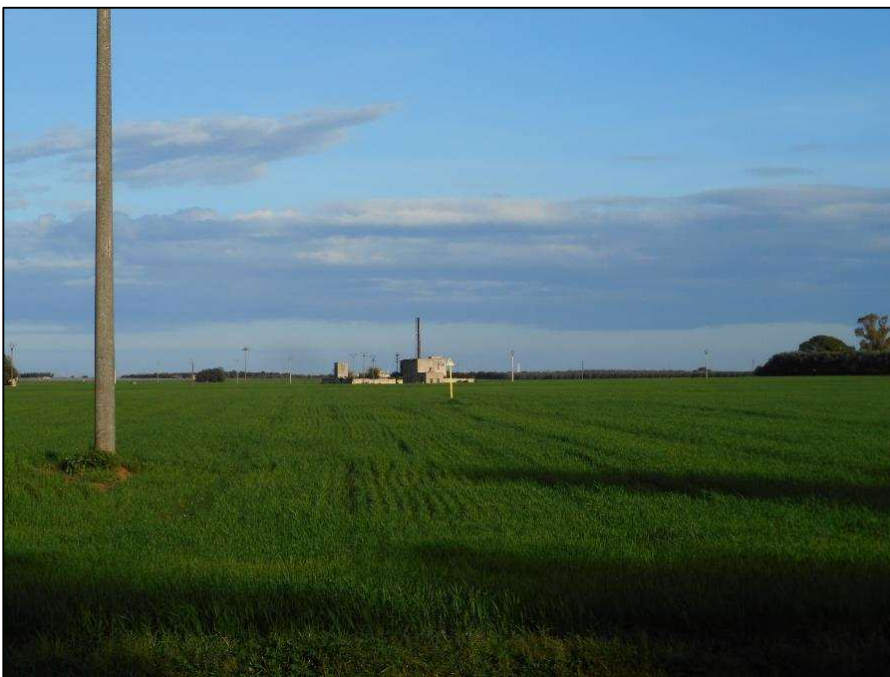
26. Mesagne (BR), Masseria Acquaro-Strada Provinciale 44 “Acquaro”, nuovo tracciato del metanodotto visto da W.
