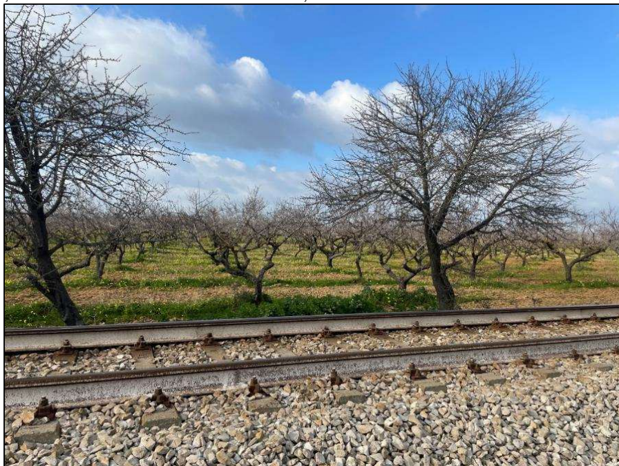
10. Brindisi, Ponte San Giorgio-Linea Ferroviaria Brindisi-Taranto, nuovo tracciato del metanodotto visto da SE.
