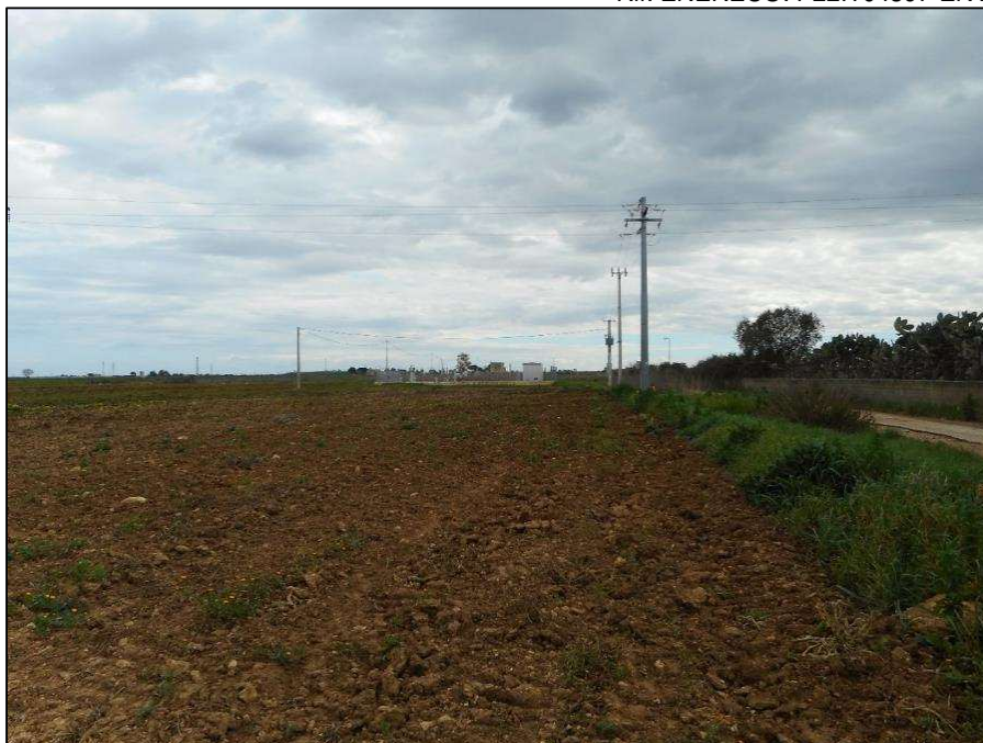
7. Brindisi, Ponte San Giorgio-Strada Statale 7, tratto del nuovo tracciato del metanodotto visto da SE.
