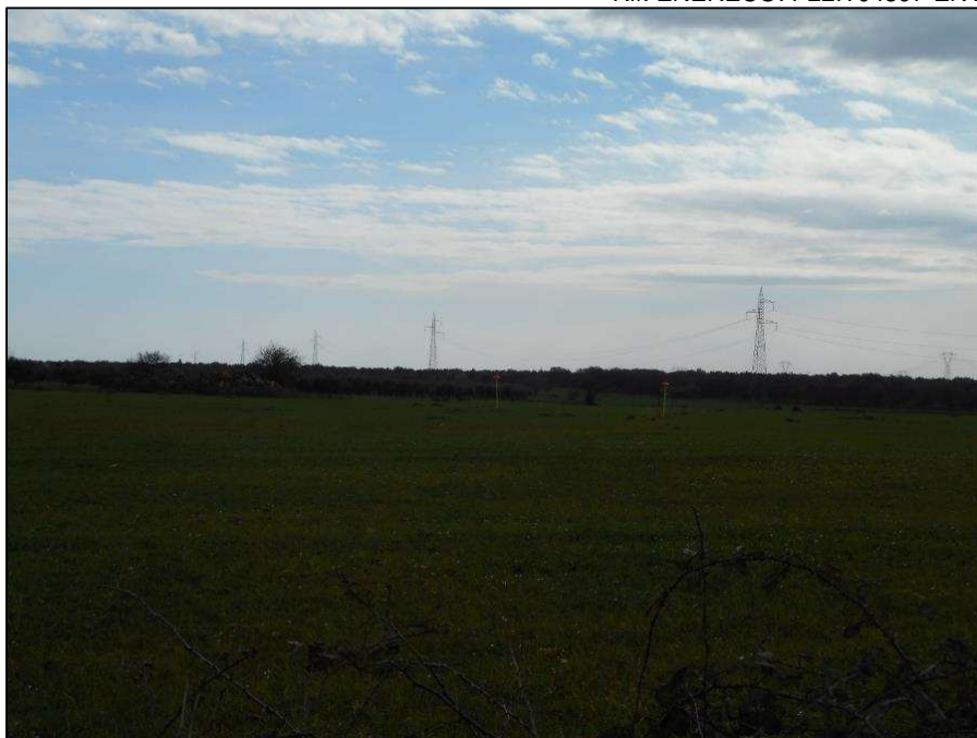
45. Latiano (BR), Masseria Marangiosa, nuovo tracciato del metanodotto visto da E.
