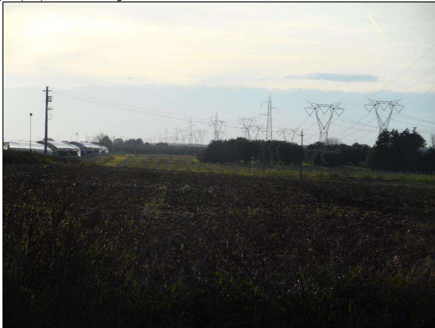
32. Mesagne (BR), Masseria Argiano-Strada Provinciale 37, nuovo tracciato del metanodotto visto da E.
