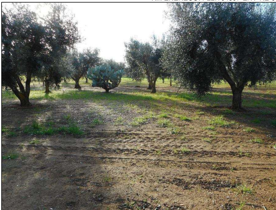
25. Brindisi, Masseria Acquaro-Strada Comunale 51, nuovo tracciato del metanodotto visto da WSW.
