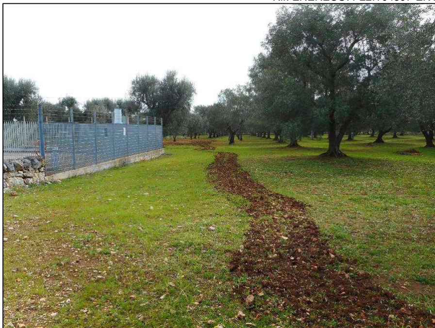
49. San Vito dei Normanni (BR), località Sardella di San Michele-Masseria Grattile, area del PIL n. 4 del metanodotto vista da W.
