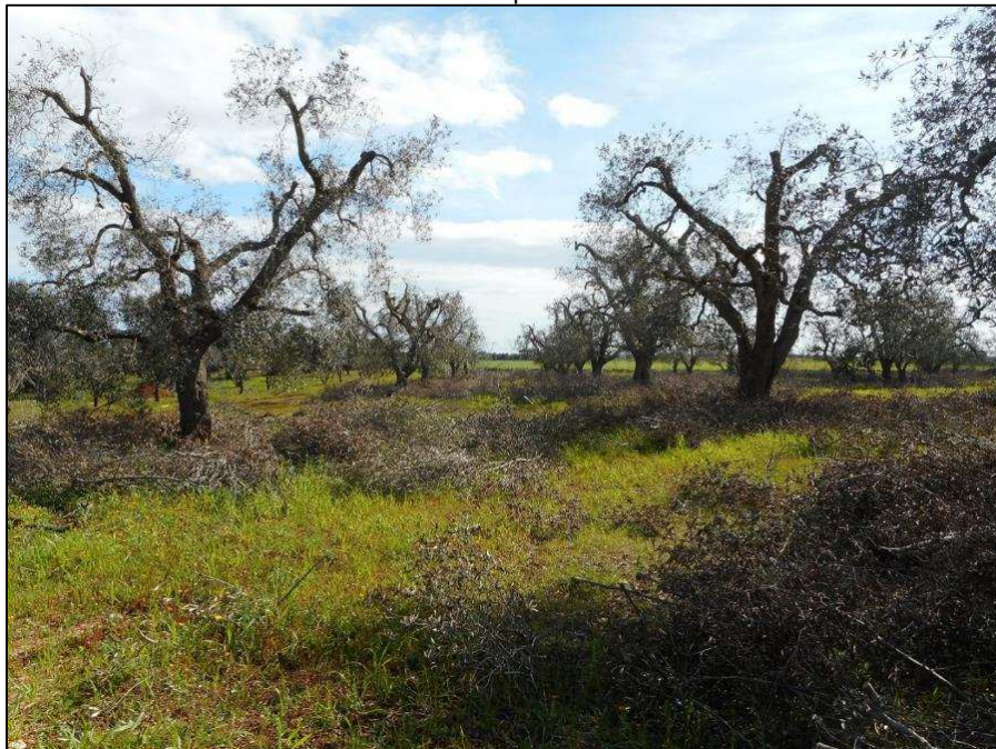
58. San Michele Salentino (BR), località Forleo la Mendola, nuovo tracciato del metanodotto che attraversa un uliveto visto da W.
