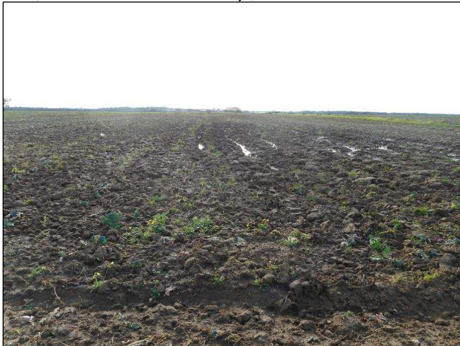
18. Brindisi, Masseria Masciullo-Canale Cillareys, nuovo tracciato del metanodotto visto da E.
