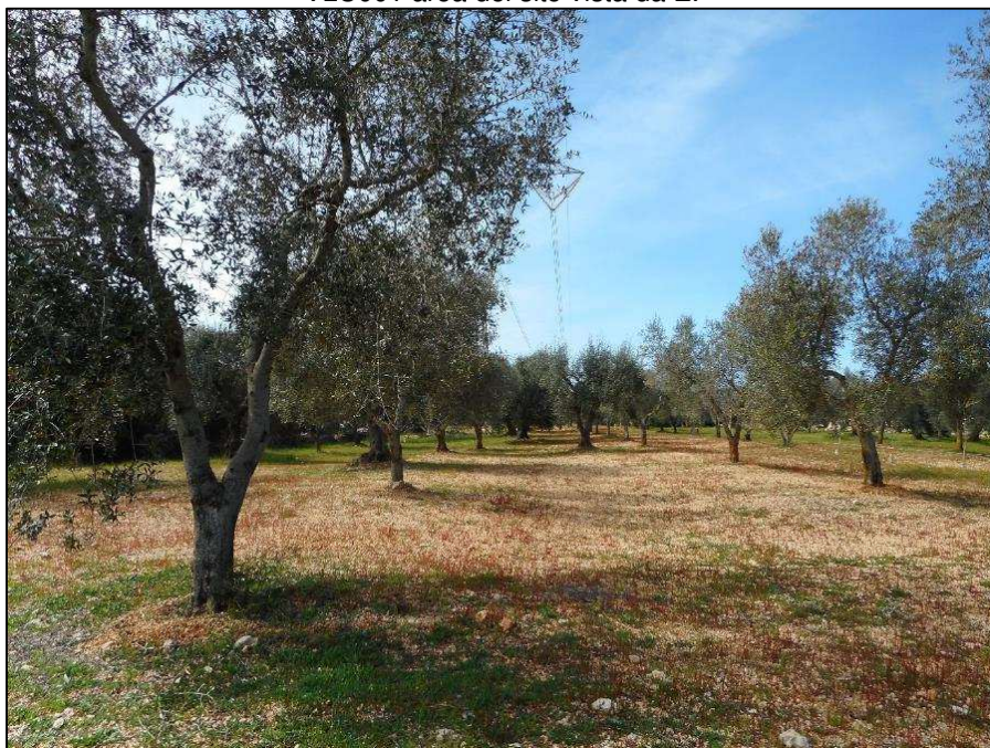
84. Villa Castelli (BR), Masseria Scotano, tracciato del metanodotto esistente nei pressi del sito noto VLC001 area del sito vista da W.
