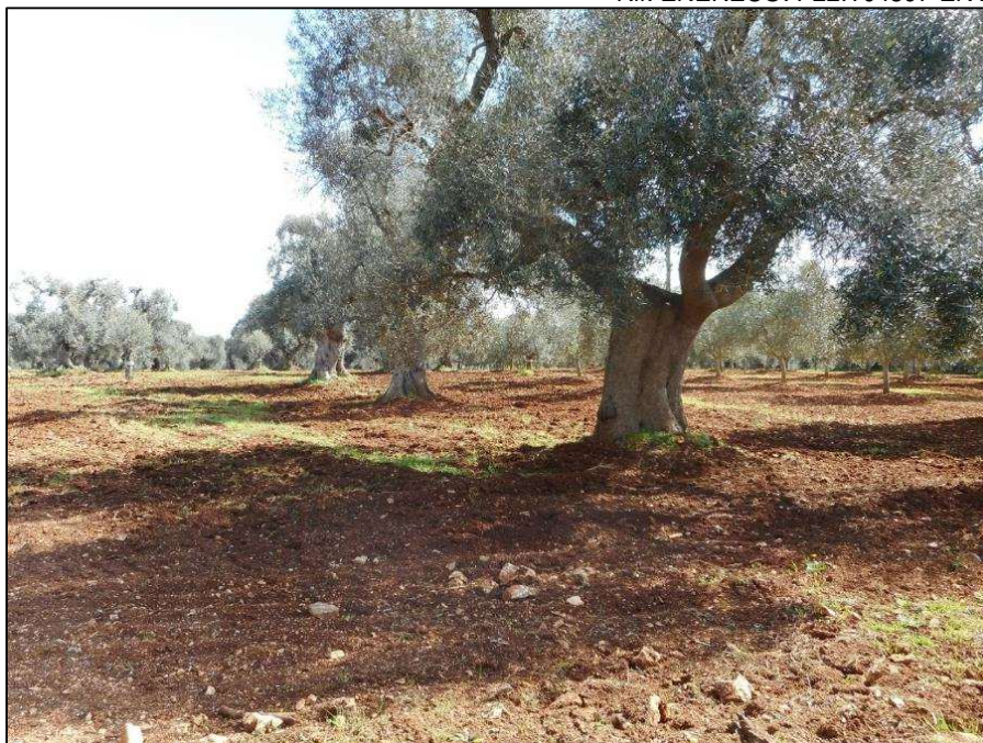
67. Francavilla Fontana (BR), Masseria Serra-Strada Vecchia per Ceglie Messapica (SP 27), nuovo tracciato del metanodotto che attraversa un uliveto visto da W.
