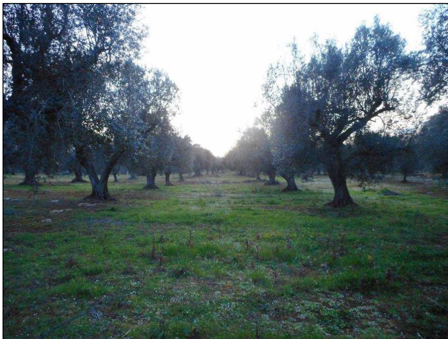
41. Latiano (BR), Masseria Ascìulo, nuovo tracciato del metanodotto visto da E.
