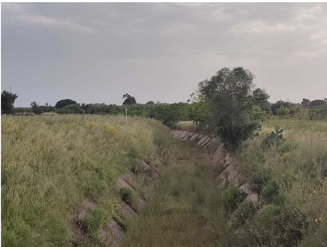
Fig. 2-2: Attraversamento 2 Canale Cerrito
