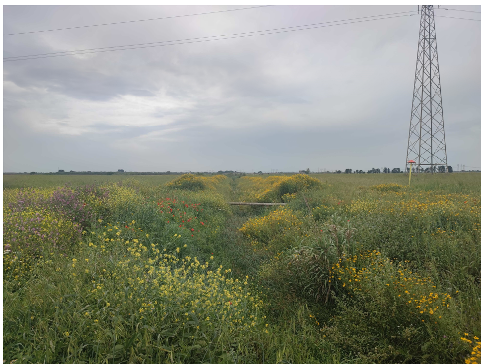
Fig. 2-1: Attraversamento 1 Canale Cerrito
