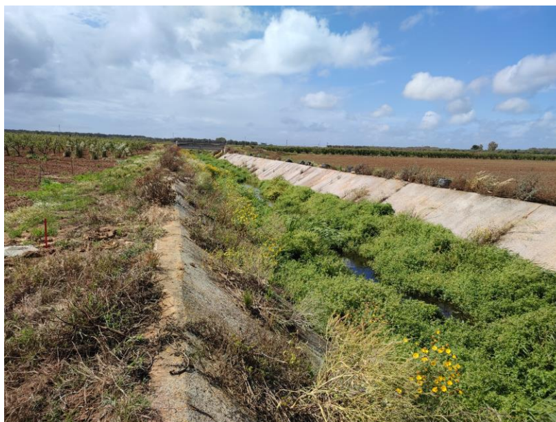
Fig. 2-1: attraversamento del Canale Galina
