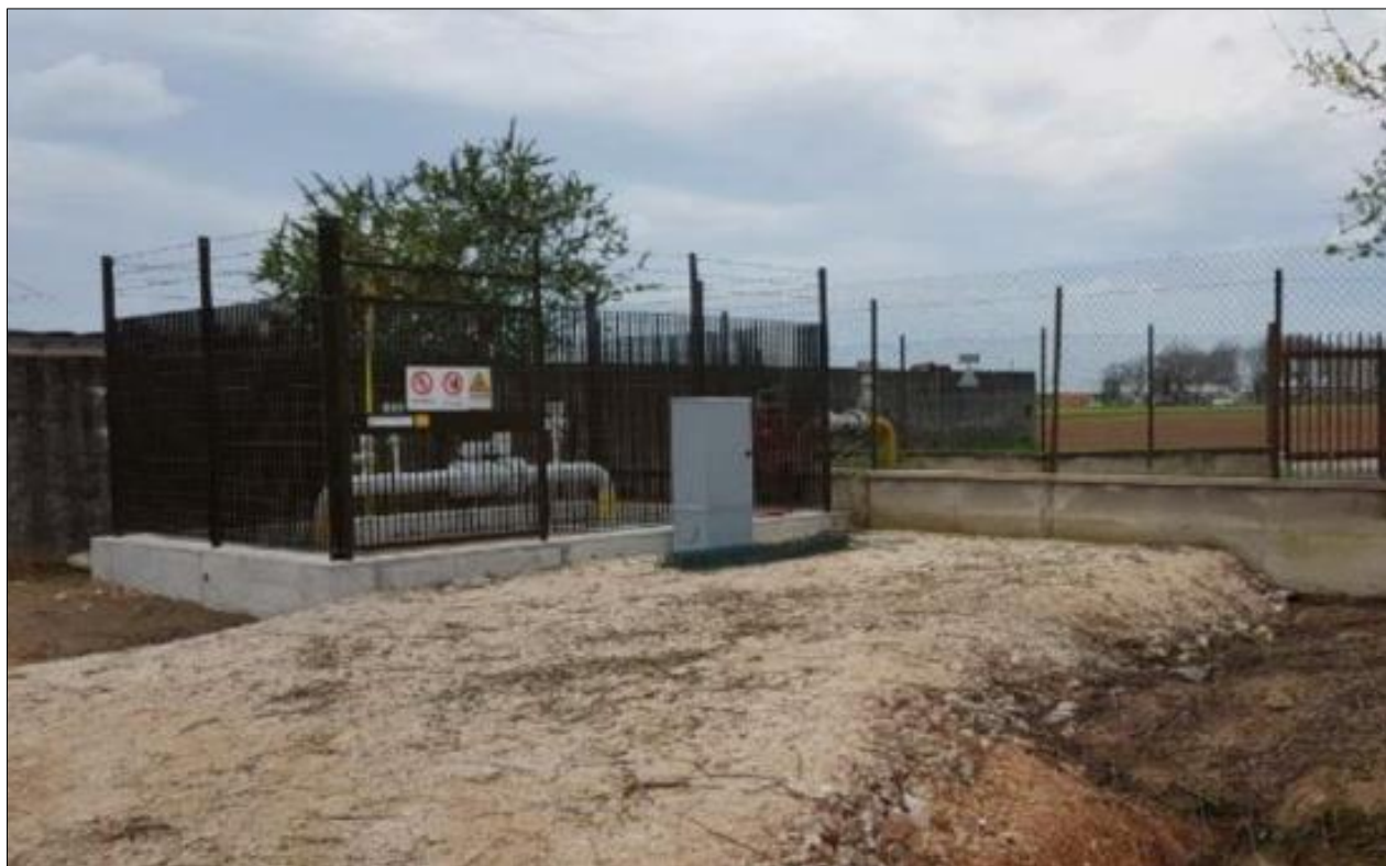
Fig. 7-17: Esempio di impianto al termine dei lavori.
