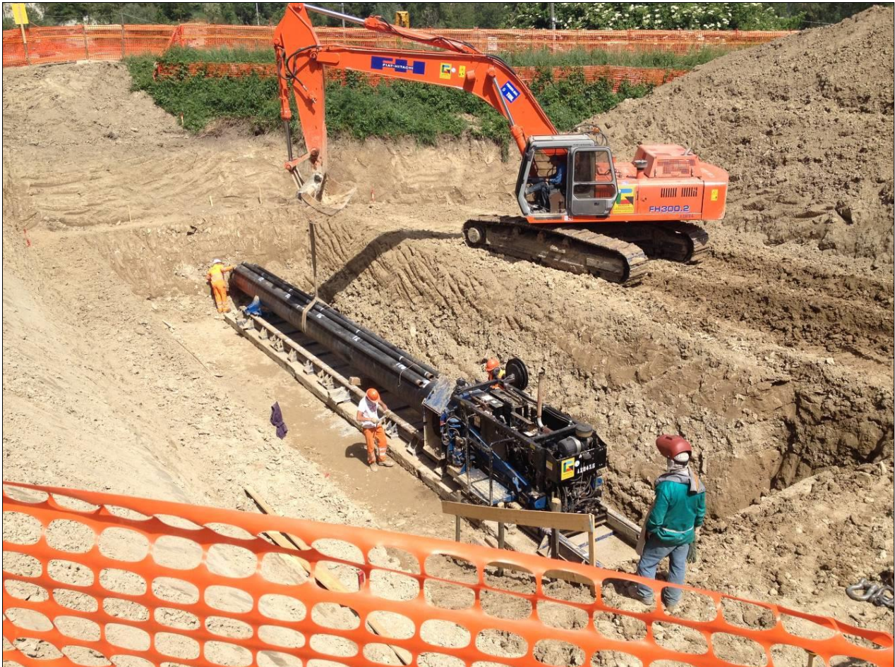
Fig. 7-16: Trivella spingitubo
