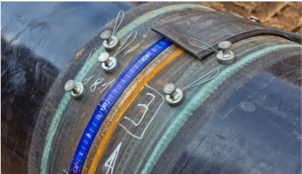
Fig. 7-7: Controlli non distruttivi sulla saldatura
