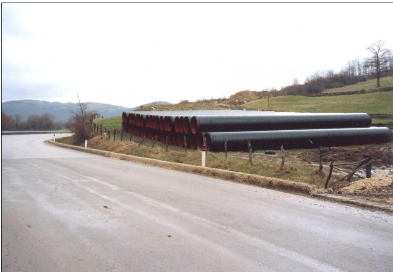
Fig. 7-1: Piazzole di accatastamento tubazioni.
