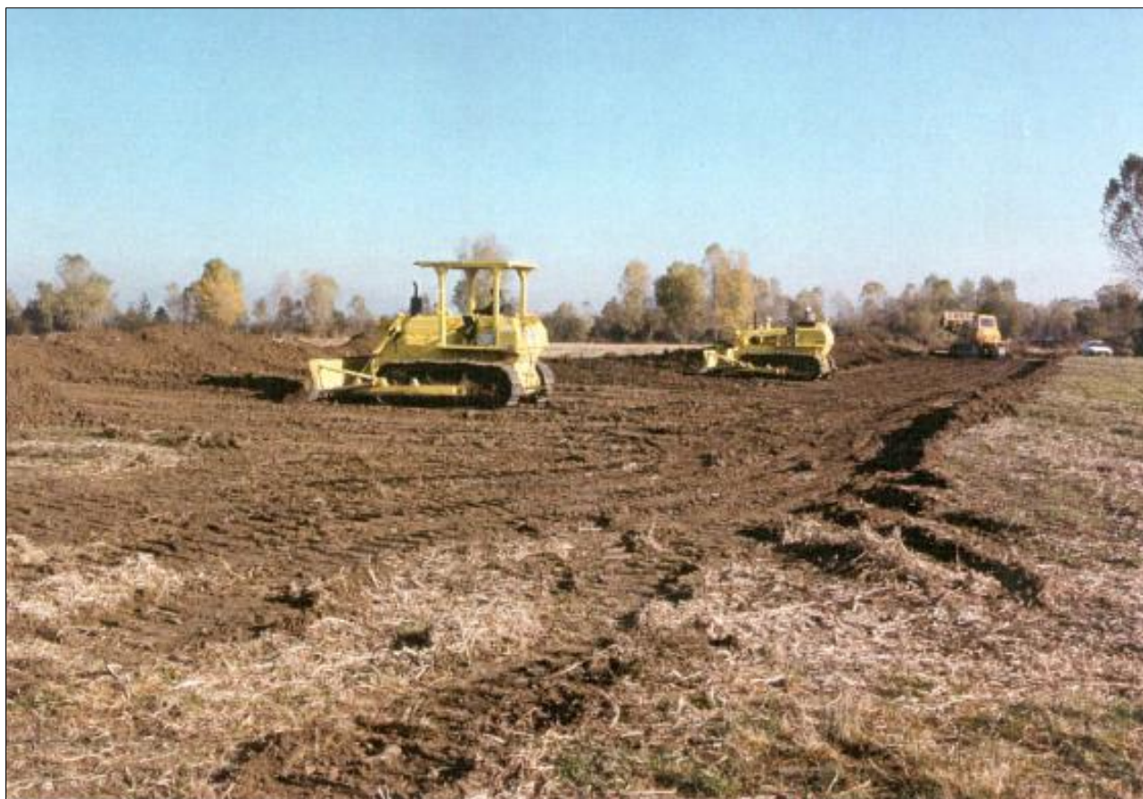
Fig. 7-2: Apertura dell'area di passaggio
