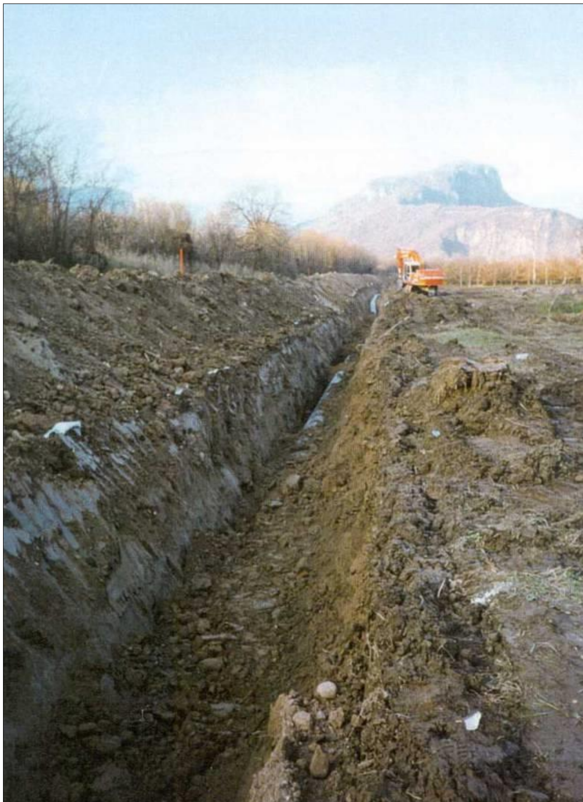
Fig. 7-11: Operazioni di rinterro della condotta
