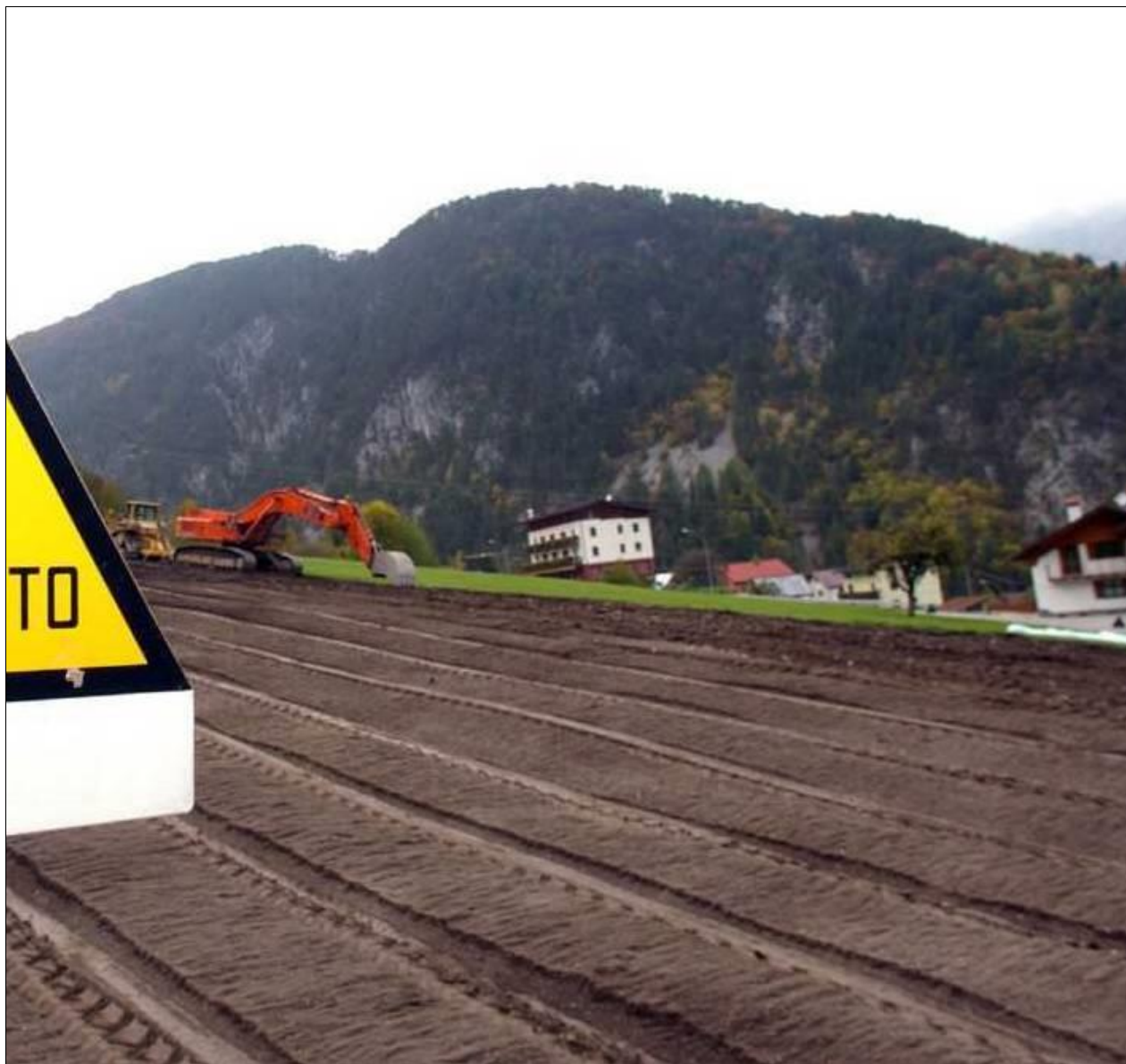
Fig. 7-12: Ridistribuzione dello strato humico superficiale
