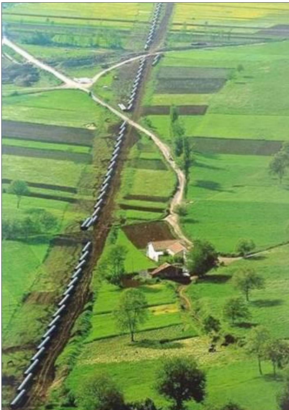
Fig. 7-4: Sfilamento dei tubi lungo la linea
