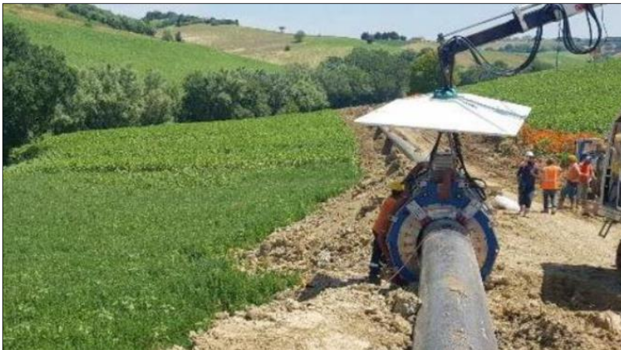
Fig. 7-6: Saldatura automatica
