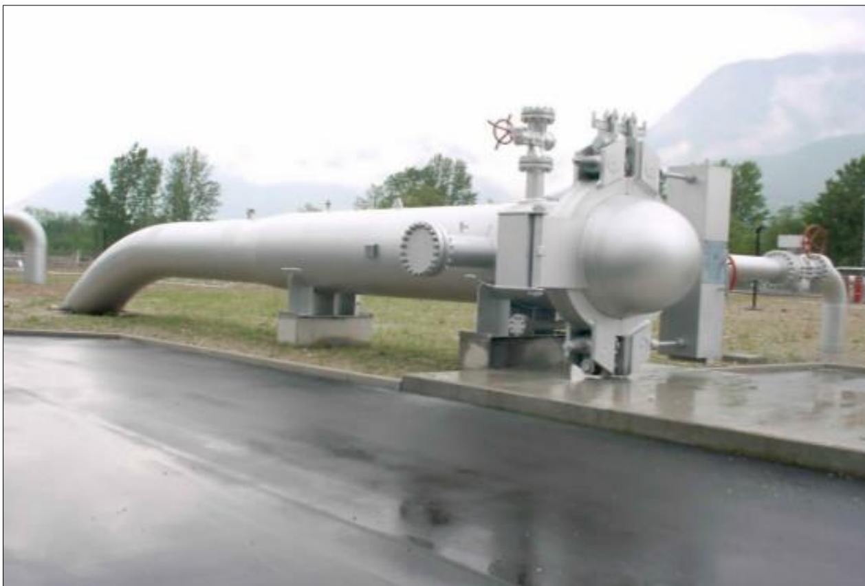
Fig. 7-18: Punto di lancio e ricevimento pig
