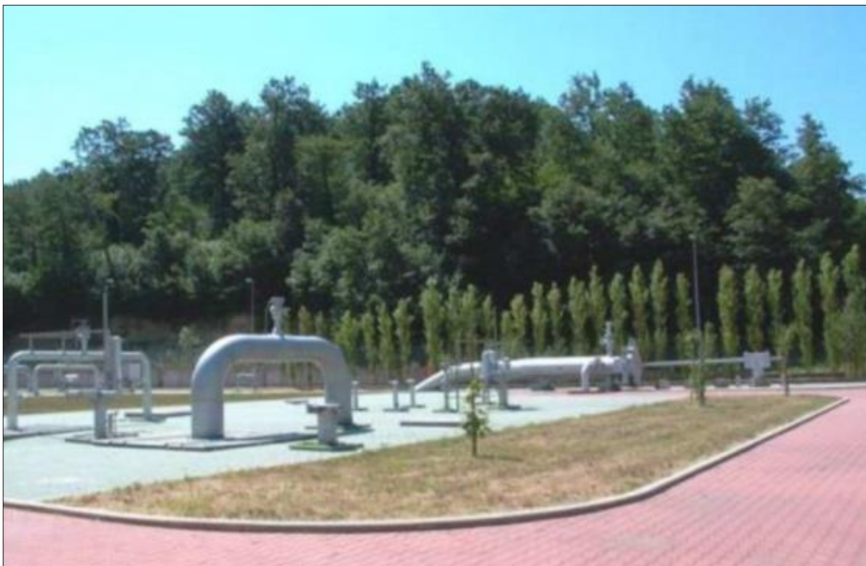
Fig. 7-19: Allestimento area trappola
