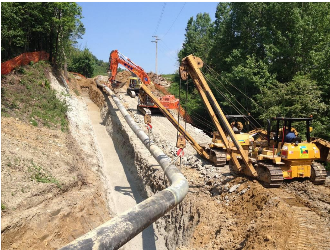
Fig. 7-10: Sollevamento e posa della colonna
