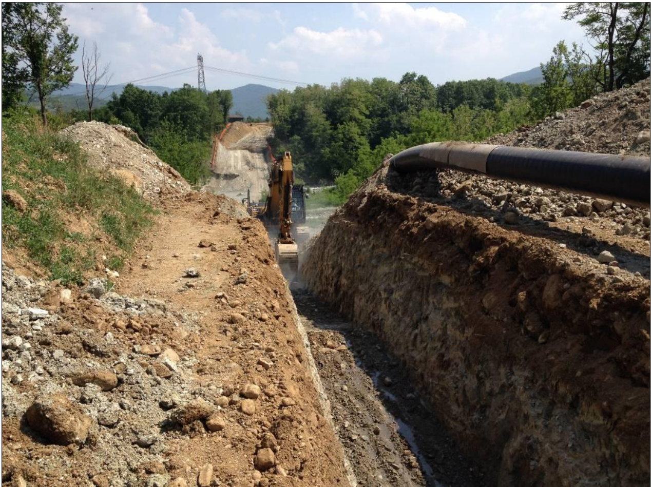
Fig. 7-8: Scavo della trincea
