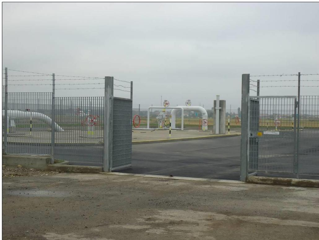
**Figura 3.2 - Esempio di stazione lancio e ricevimento PIG.**
