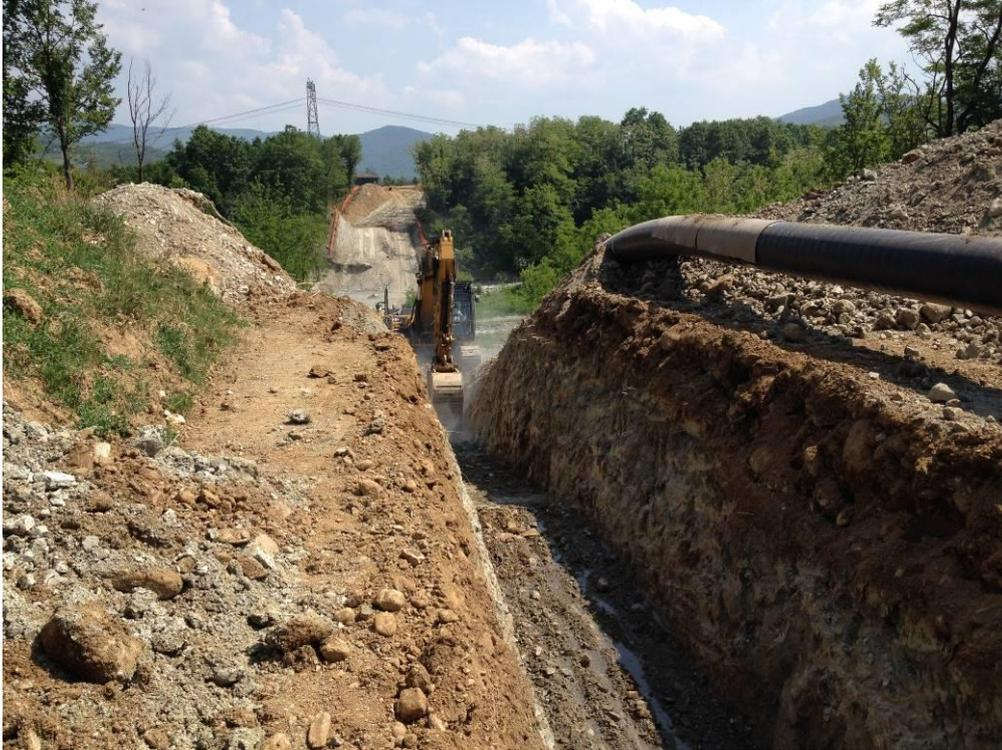
**Figura 4.4 - Scavo per l'alloggiamento della condotta.**
