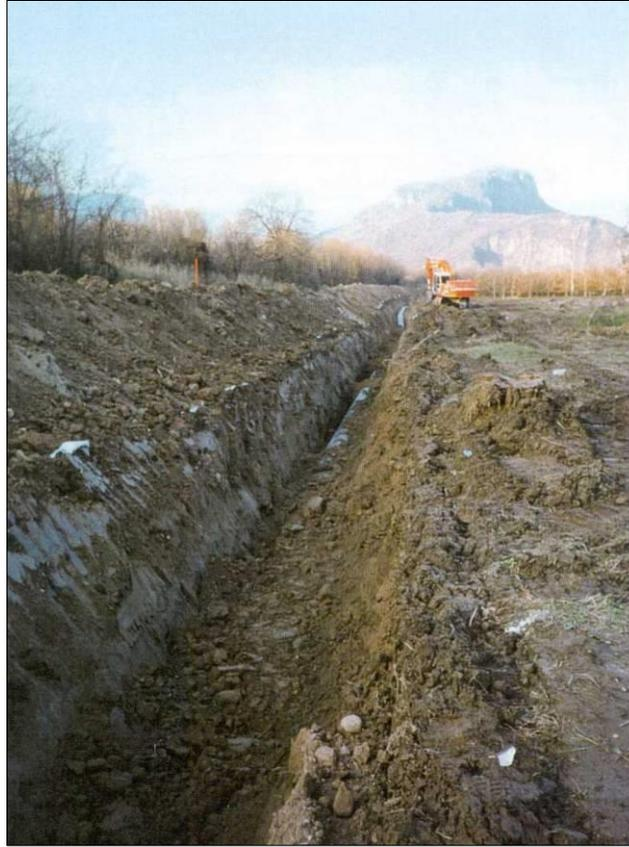
**Figura 4.6 - Operazione di rinterro della condotta.**
