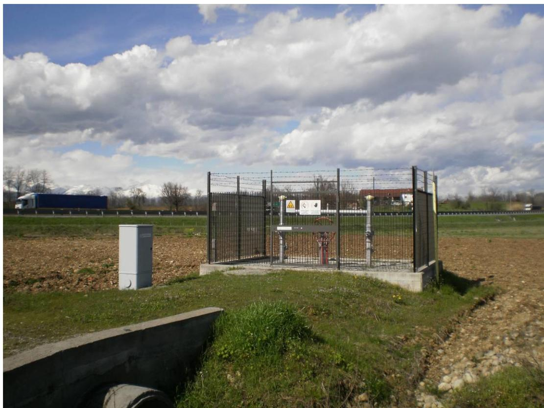
**Figura 4.12 - Esempio di impianto di intercettazione di linea PIL**
