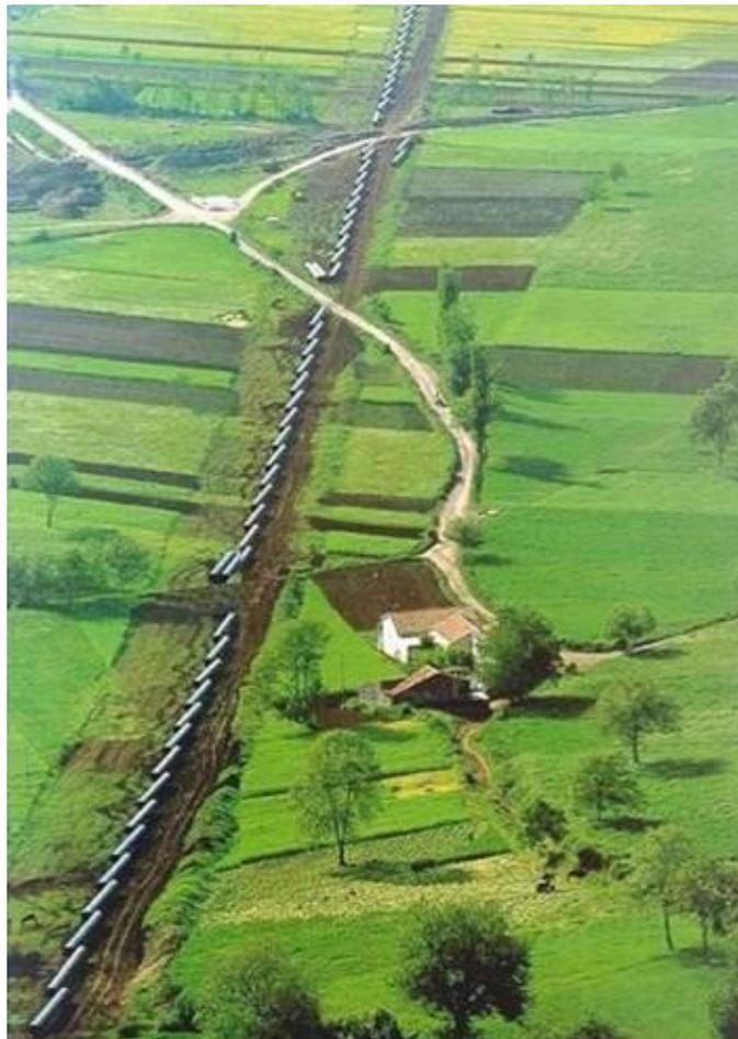
**Figura 4.2 - Sfilamento dei tubi lungo la linea.**
