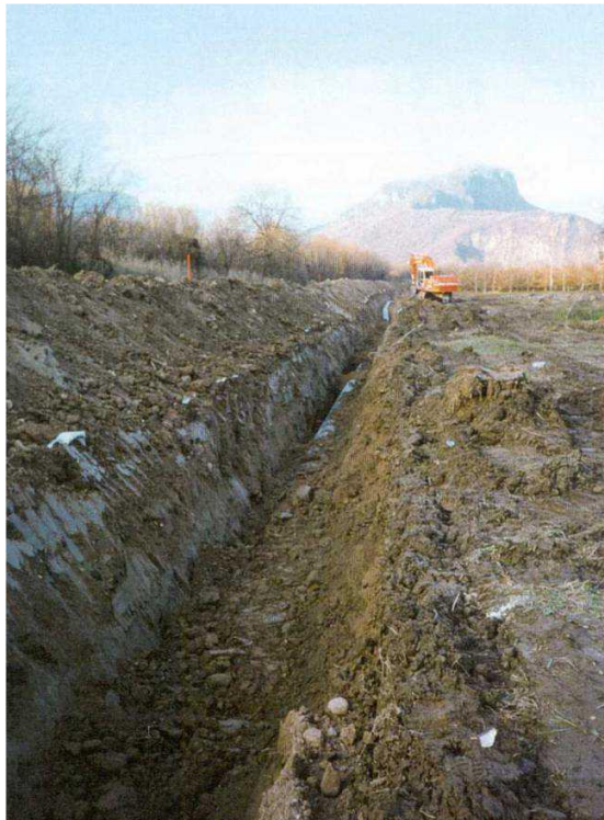
Figura 1. 8 - Operazione di rinterro della condotta
