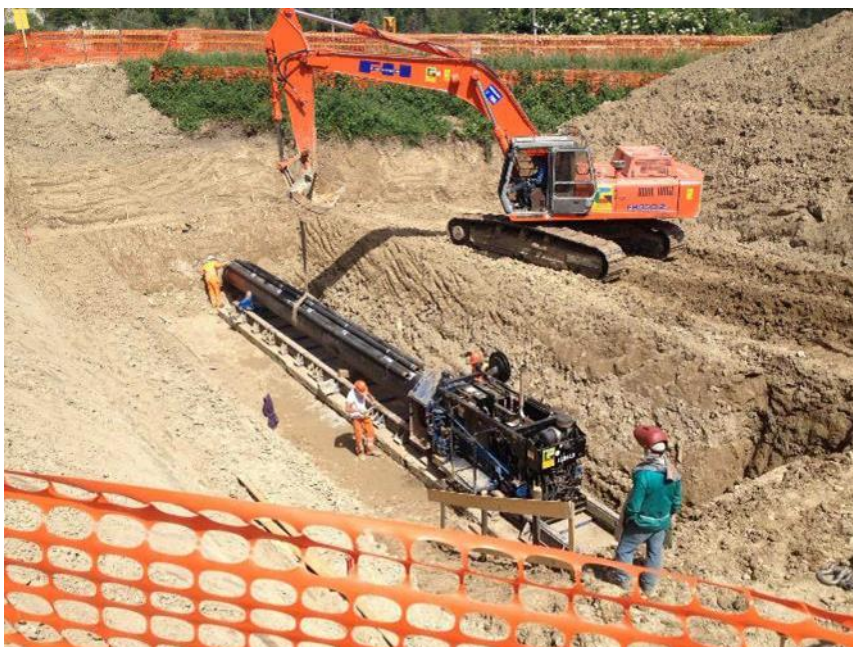
Figura 1. 13 - Trivella spingitubo
