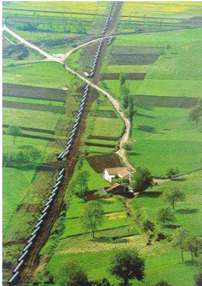
Figura 1. 4 - Sfilamento dei tubi lungo la linea
