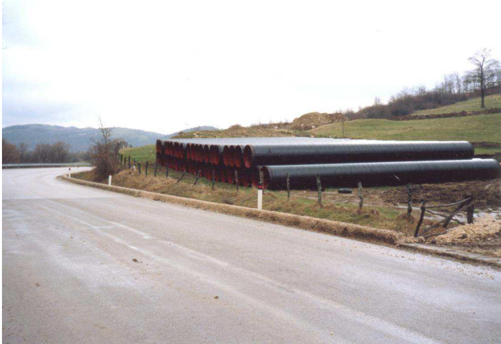
Figura 1. 1 - Piazzole di accatastamento tubazioni
