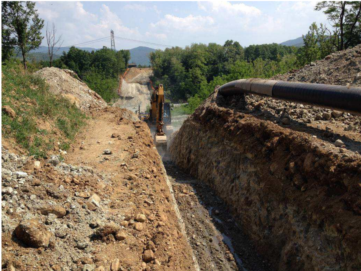
Figura 1. 6 - Scavo per l'alloggiamento della condotta
