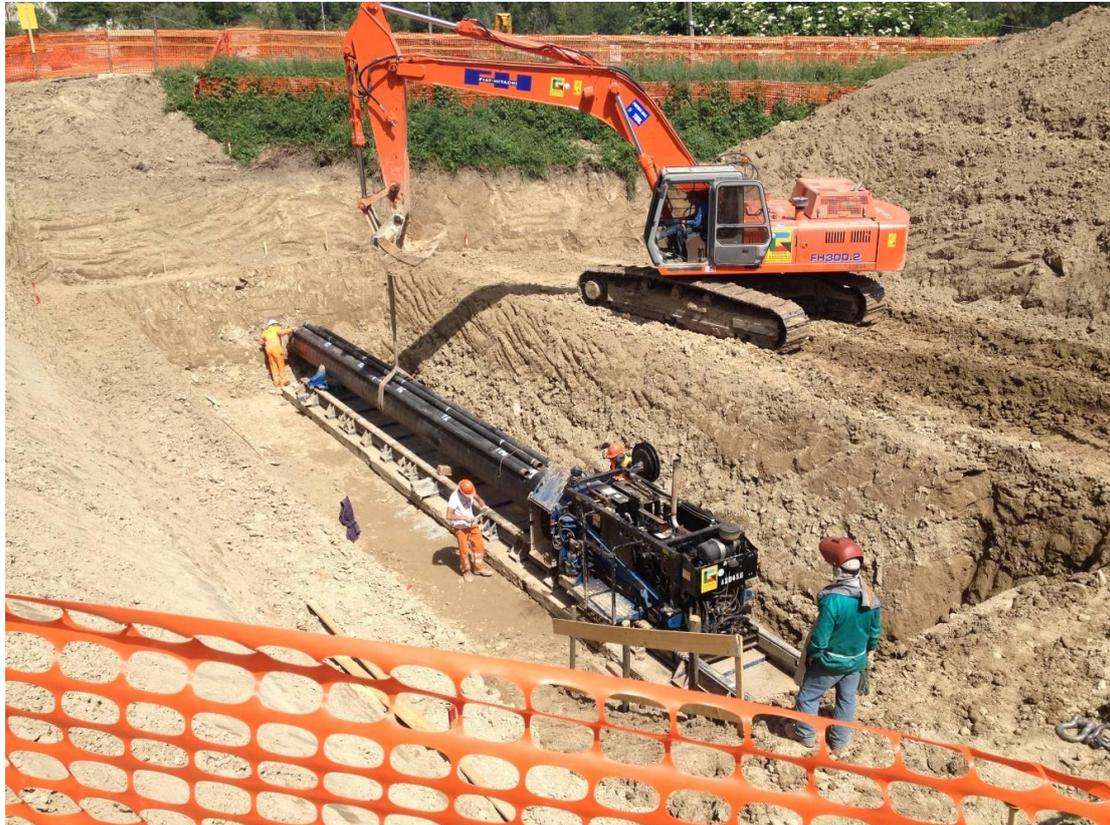
**Fig. 4-5 - Trivella spingitubo**
