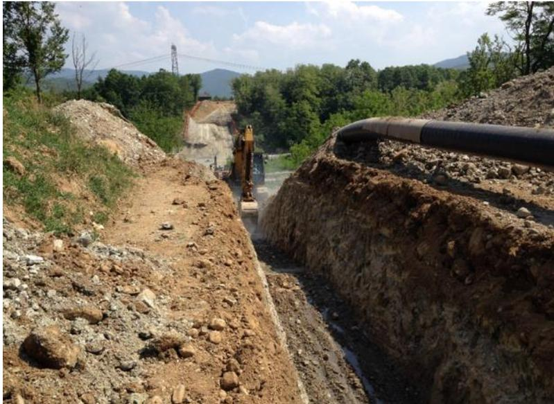
**Fig. 4-4 - Scavo per l'alloggiamento della condotta.**
