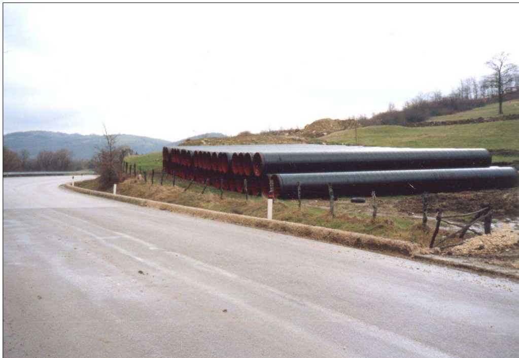
Figura 5.3 - Piazzole di accatamento tubazioni
