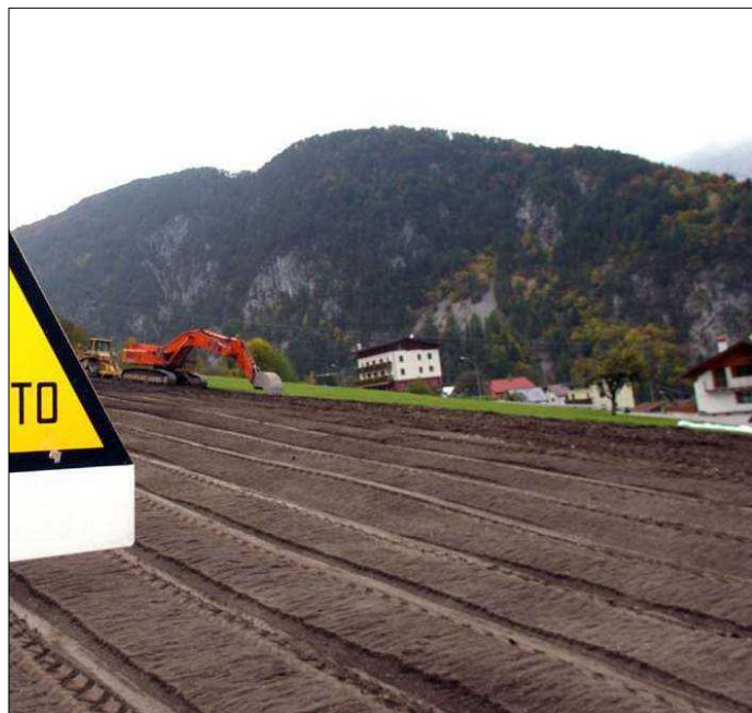
Figura 5.9 - Ridistribuzione dello strato humico superficiale.
