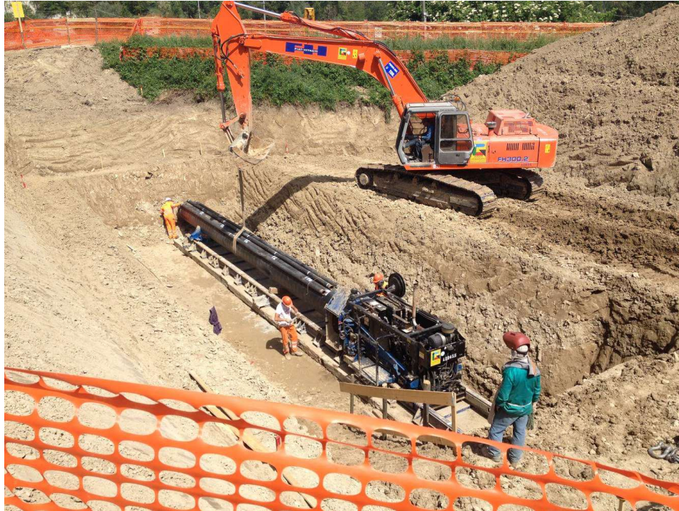
Fig. 5-1 - Trivella spingitubo
