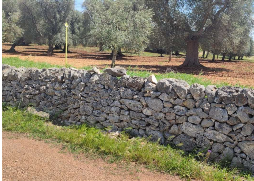
Figura 1.13 – Tipico muretto a secco nell’area di intervento
