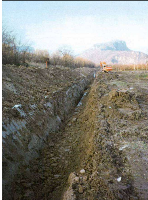
Figura 5.8 - Operazione di rinterro della condotta.
