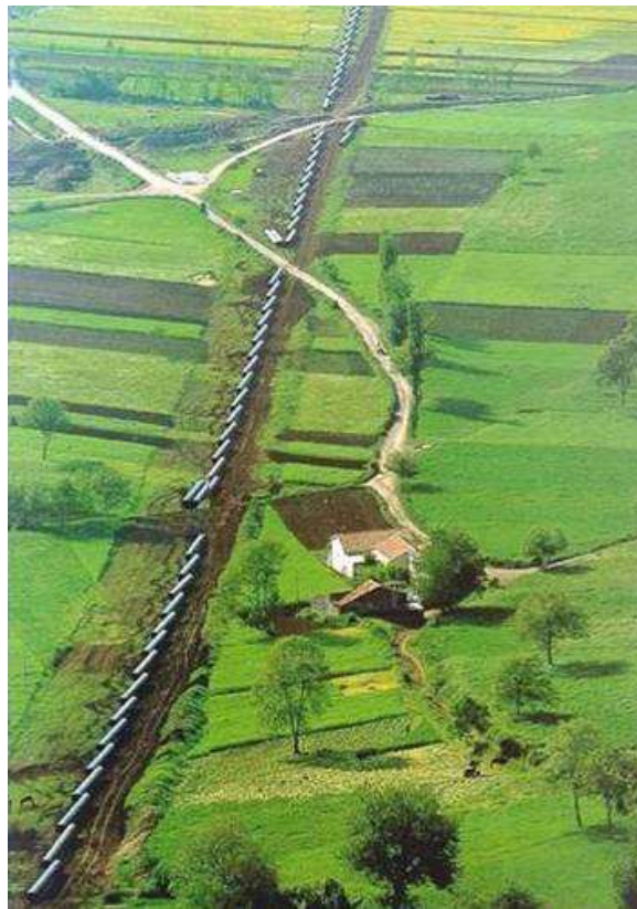
Figura 5.4 - Sfilamento dei tubi lungo la linea.
