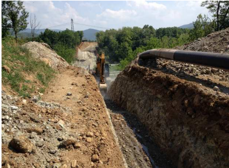
Figura 3.3 - Scavo per l'alloggiamento della condotta.
