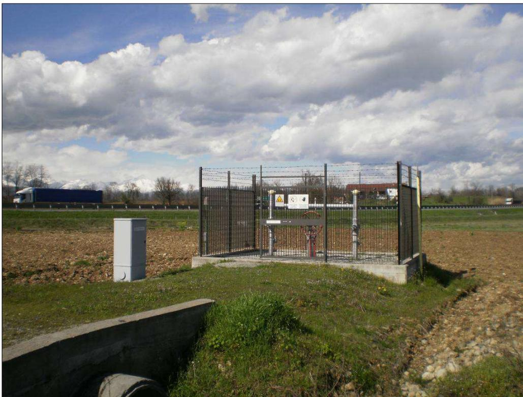
**Figura 3.1 - Esempio di impianto di intercettazione di linea PIL**
