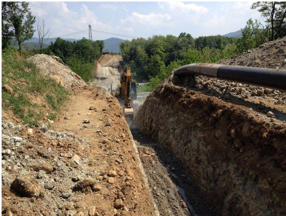
**Figura 3.6 - Scavo per l'alloggiamento della condotta.**
