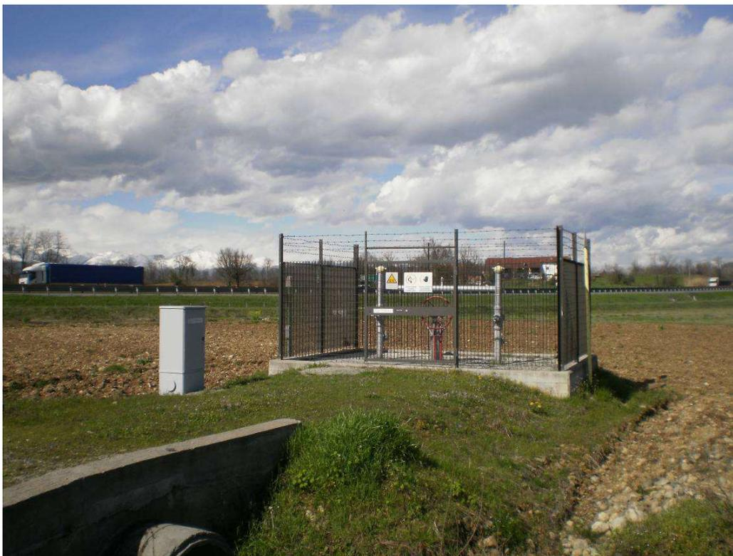
**Figura 3.10 - Esempio di impianto di intercettazione di linea PIL.**
