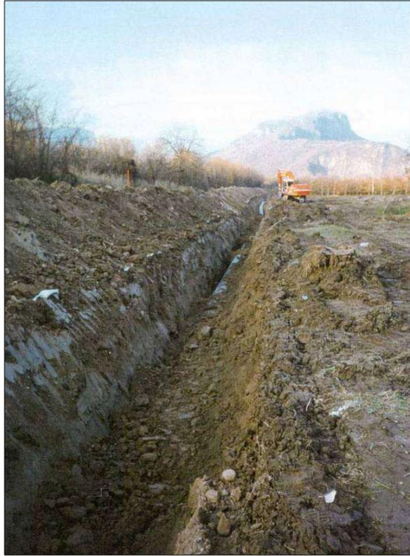
**Figura 3.8 - Operazione di rinterro della condotta.**
