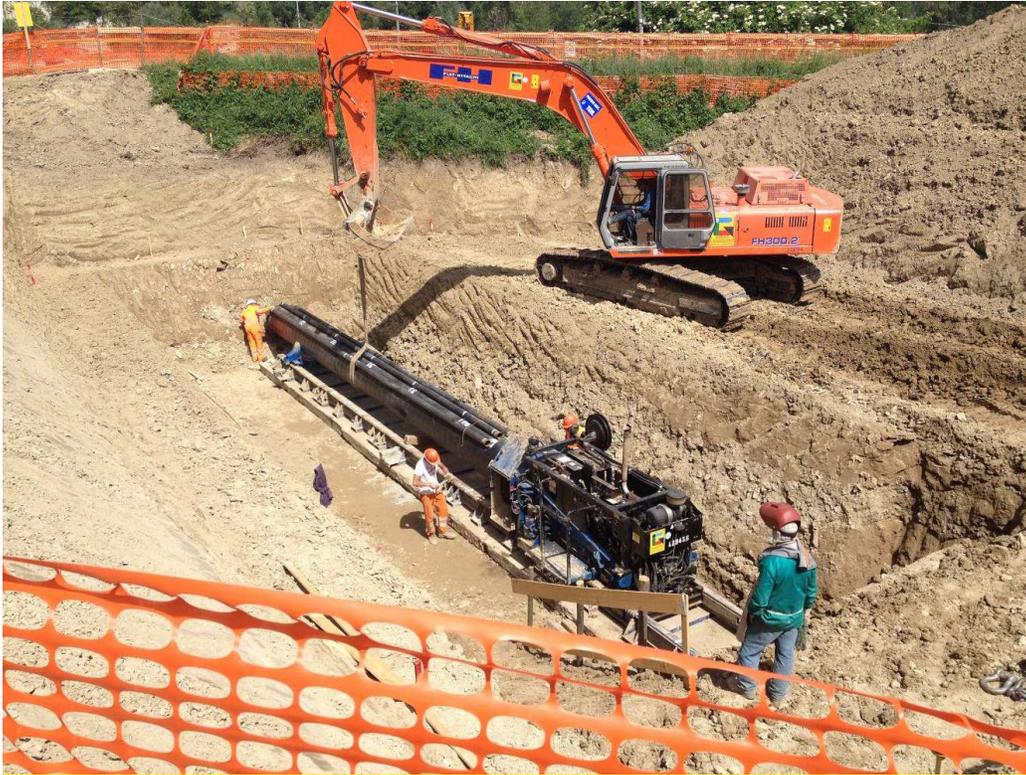
**Fig. 3-4: trivella spingitubo**
