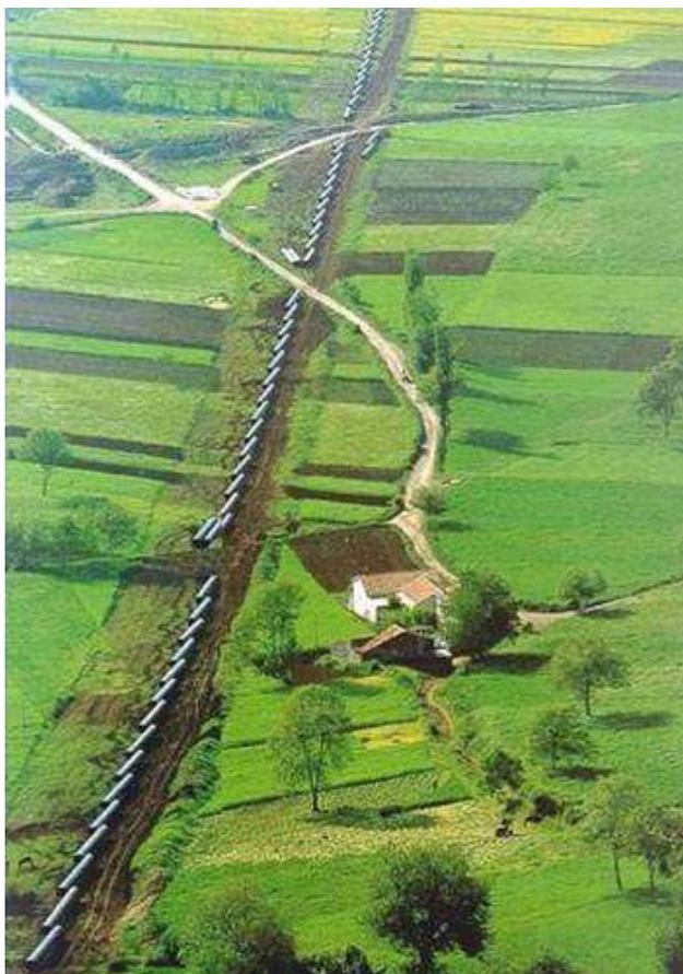
**Figura 3.4 - Sfilamento dei tubi lungo la linea.**
