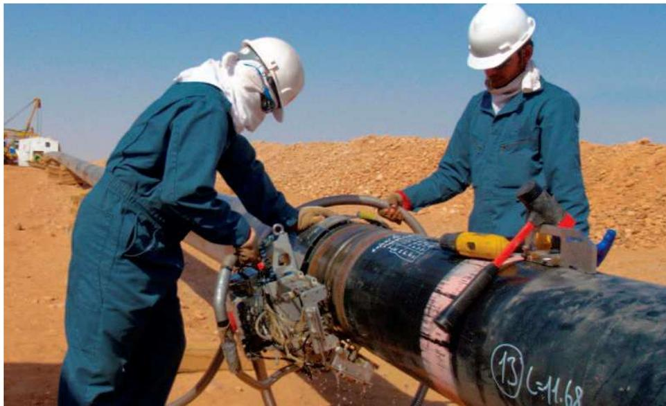
**Figura 3.5 - Saldatura.**
