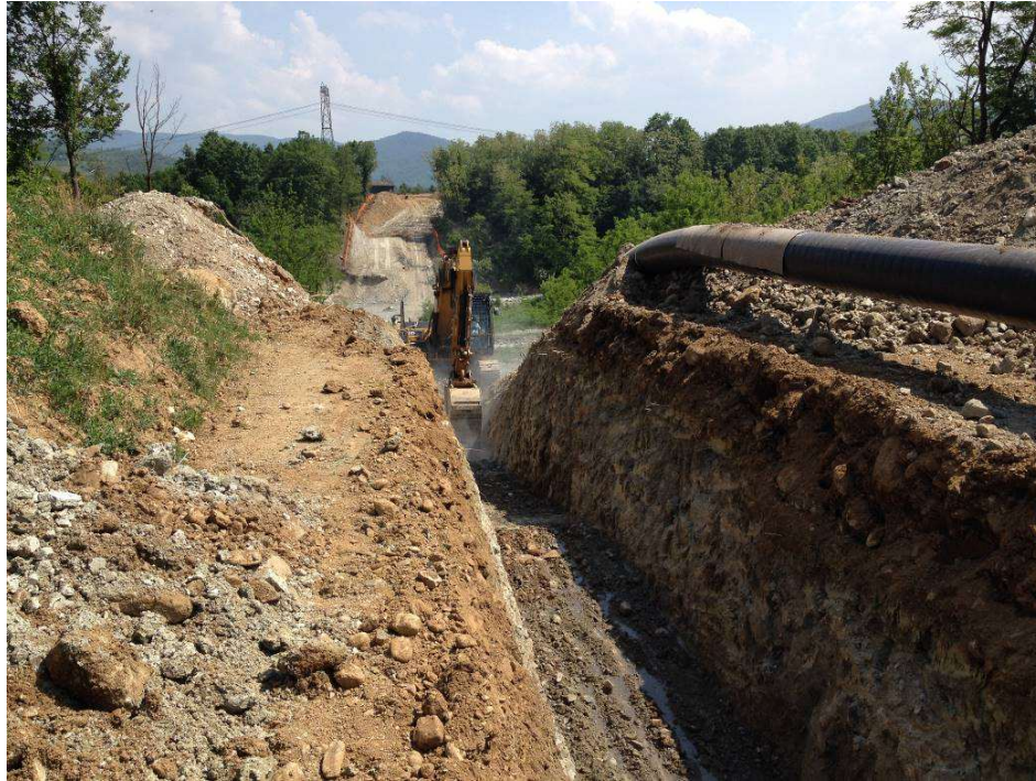
Figura 5.6 - Scavo per l'alloggiamento della condotta.
