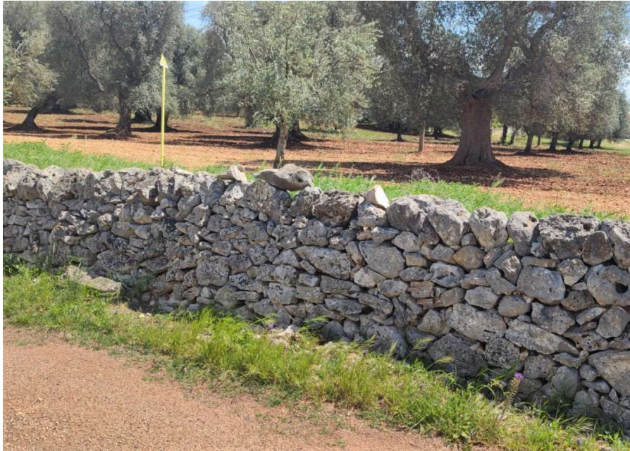
Figura 2.34 – Tipico muretto a secco nell’area di intervento
