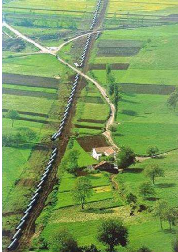
Figura 5.4 - Sfilamento dei tubi lungo la linea.
