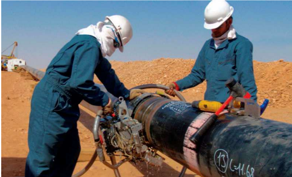
Figura 5.5 - Saldatura.
