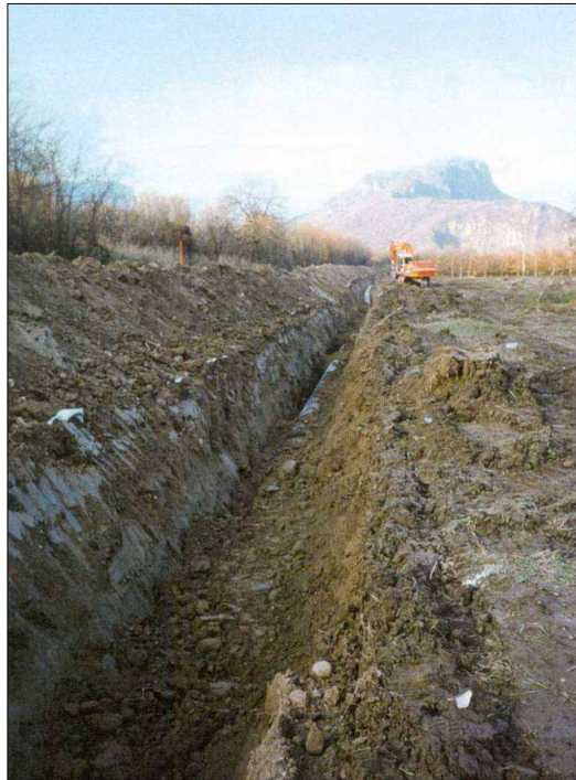
Figura 5.8 - Operazione di rinterro della condotta.
