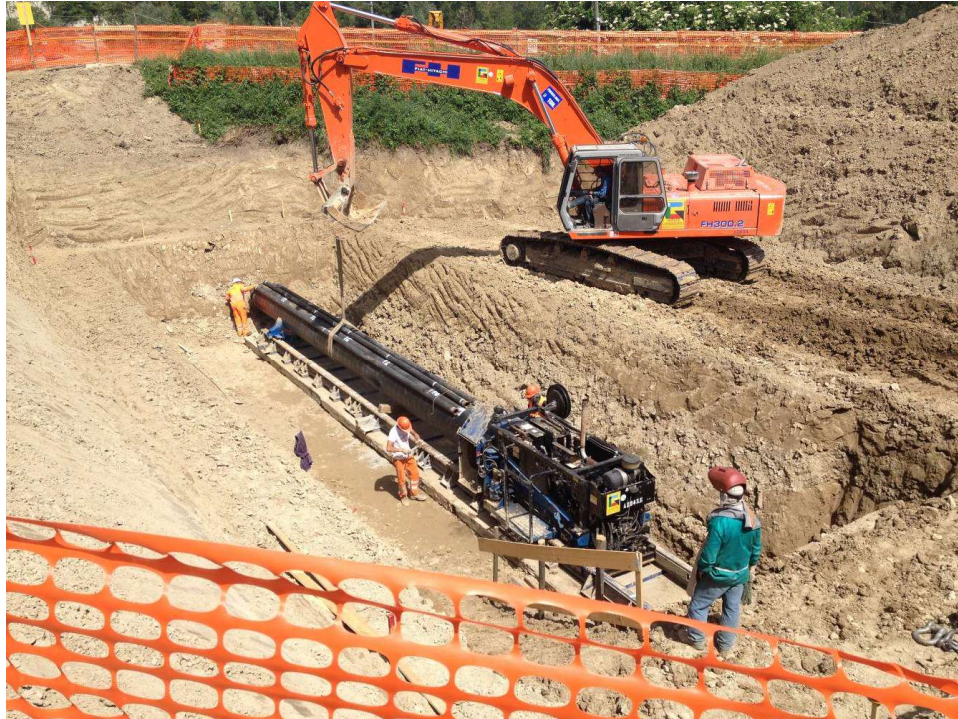
Figura 5.13 - Trivella spingitubo
