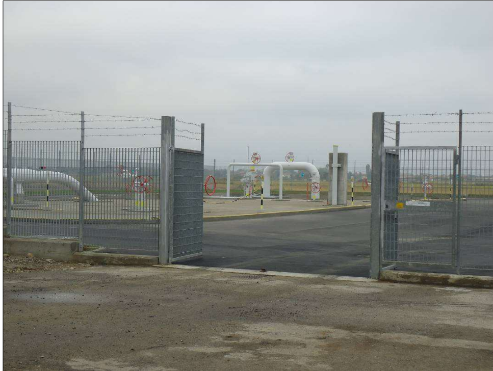
Figura 5.2 - Esempio di stazione lancio e ricevimento PIG.
