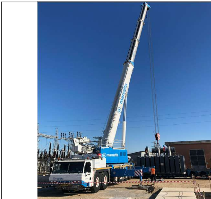
Scarico con autogru
