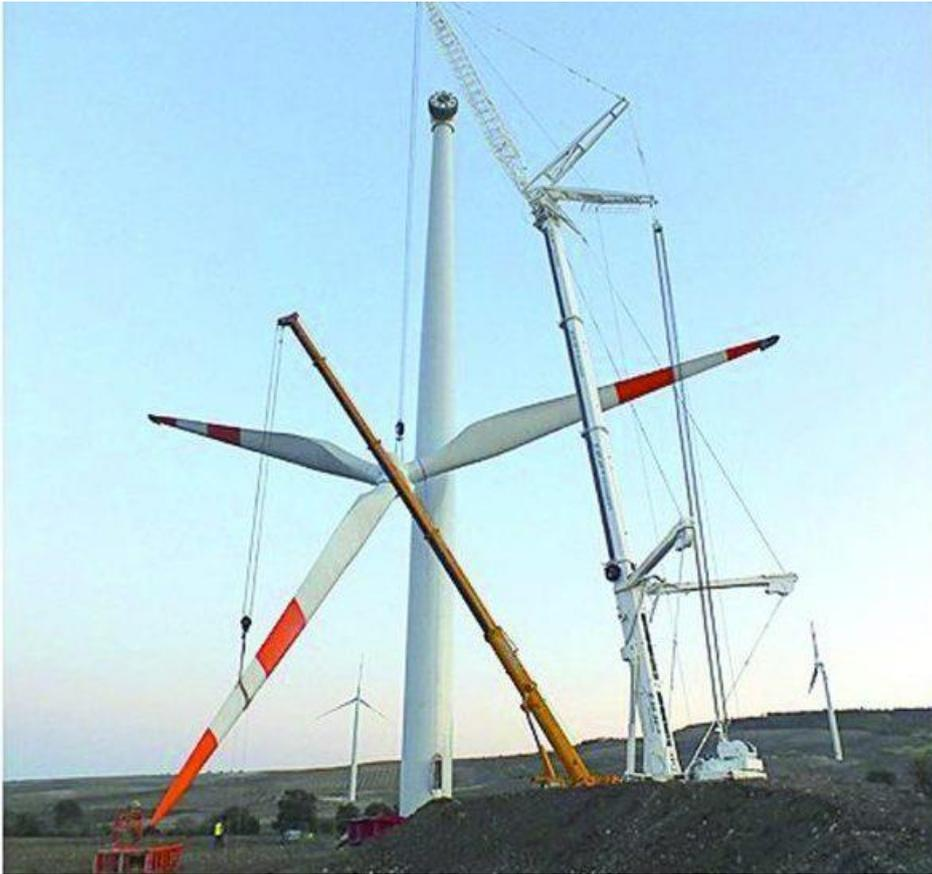
**Figura 5.4 - Fase di montaggio dell'aerogeneratore**
