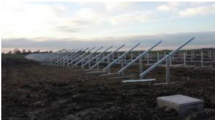
**Figura 13 – Esempio struttura fissa monopalo**
