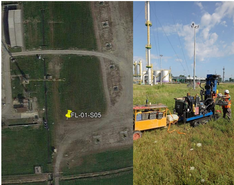
Figura 45 – ubicazione sondaggio FL01-S05 e posizionamento sonda
