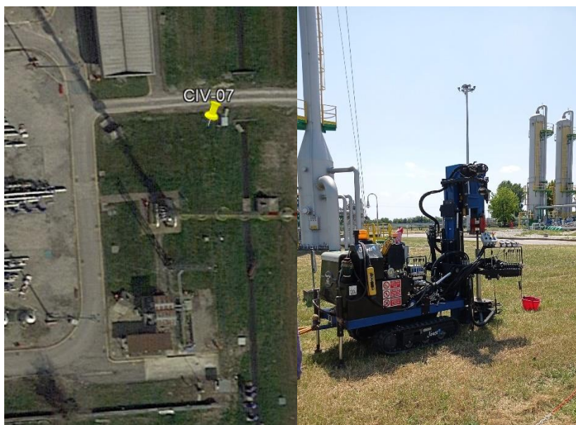
Figura 35 – ubicazione sondaggio CIV-07 e posizionamento sonda
