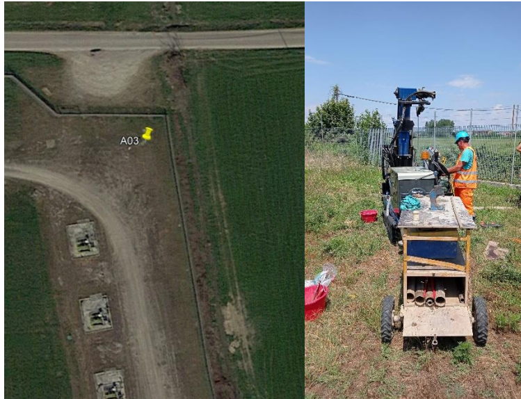
Figura 5 – ubicazione sondaggio A03 e posizionamento sonda
