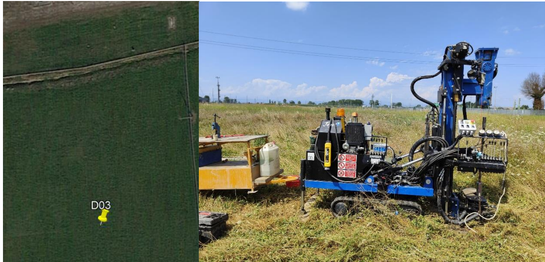
Figura 43 – ubicazione sondaggio D03 e posizionamento sonda
