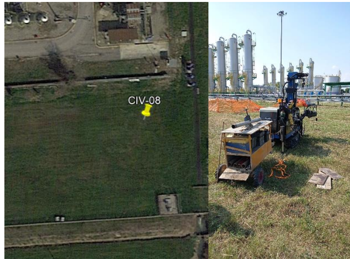
Figura 37 – ubicazione sondaggio CIV-08 e posizionamento sonda
