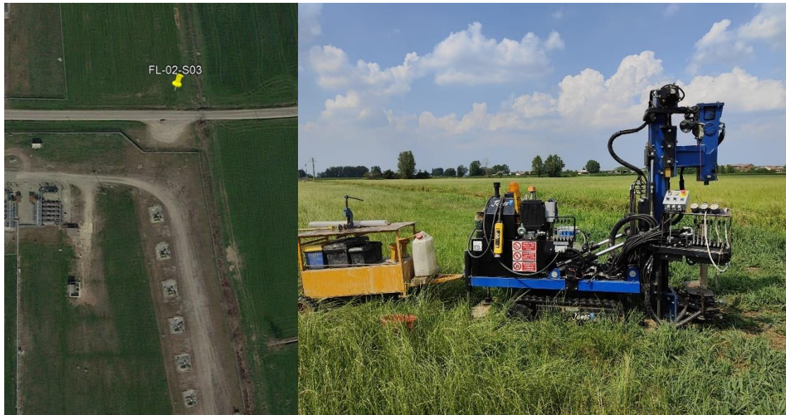
Figura 45 – ubicazione sondaggio FL02-S03 e posizionamento sonda
