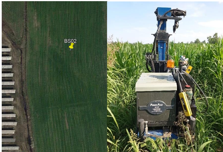
Figura 15 – ubicazione sondaggio BS02 e posizionamento sonda
