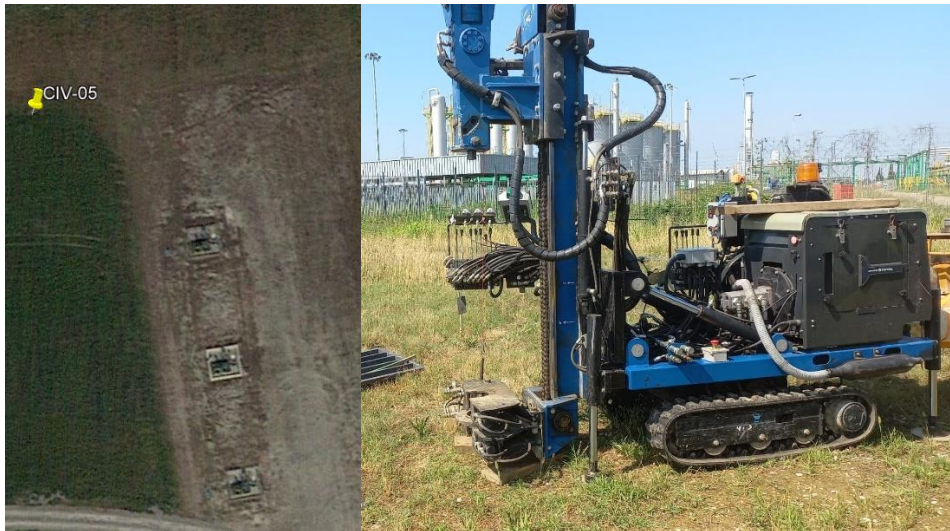
Figura 31 – ubicazione sondaggio CIV-05 e posizionamento sonda
