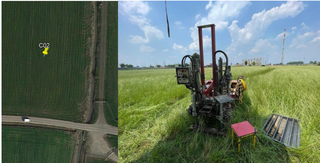
Figura 19 – ubicazione sondaggio C02 e posizionamento sonda
