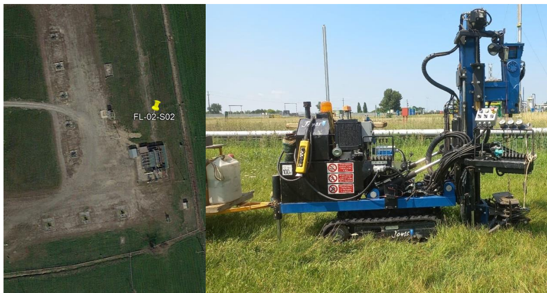
Figura 45 – ubicazione sondaggio FL02-S02 e posizionamento sonda
