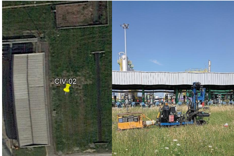
Figura 25 – ubicazione sondaggio CIV-02 e posizionamento sonda
