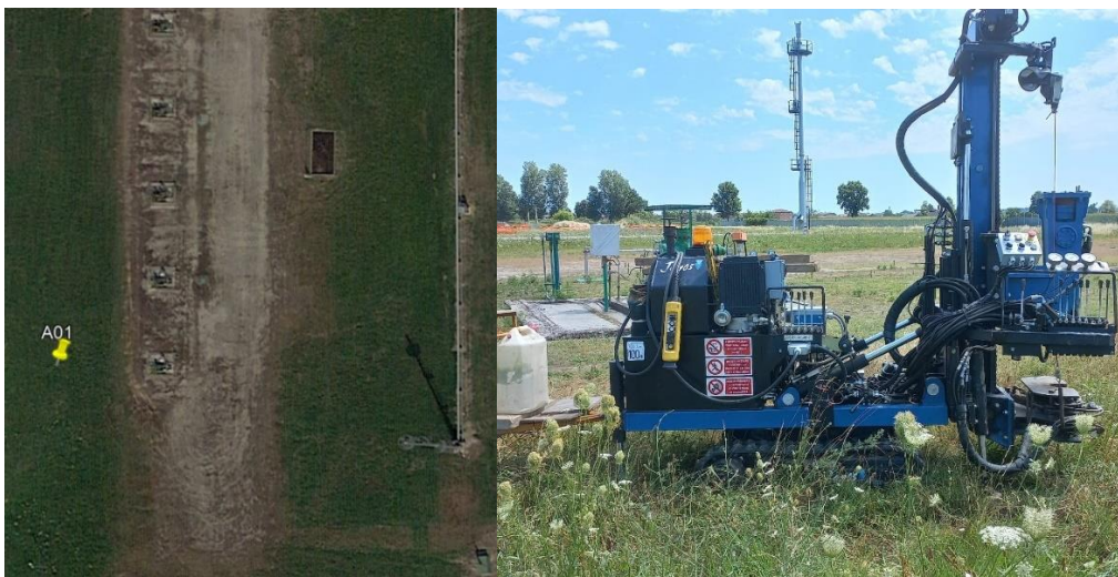
Figura 1 – ubicazione sondaggio A01 e posizionamento sonda
