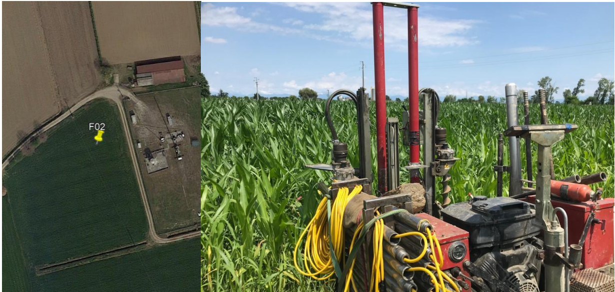
Figura 45 – ubicazione sondaggio F02 e posizionamento sonda
