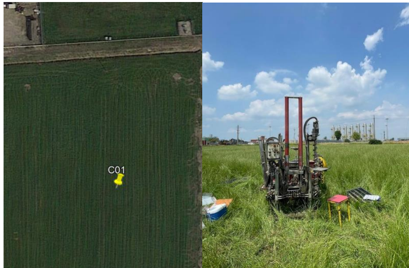
Figura 17 – ubicazione sondaggio C01 e posizionamento sonda
