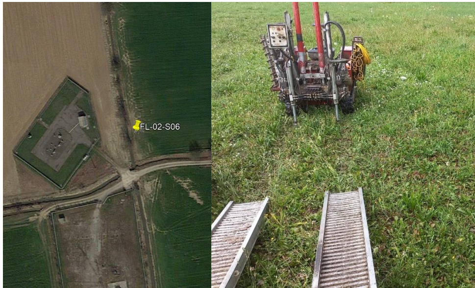
Figura 45 – ubicazione sondaggio FL02-S06 e posizionamento sonda
