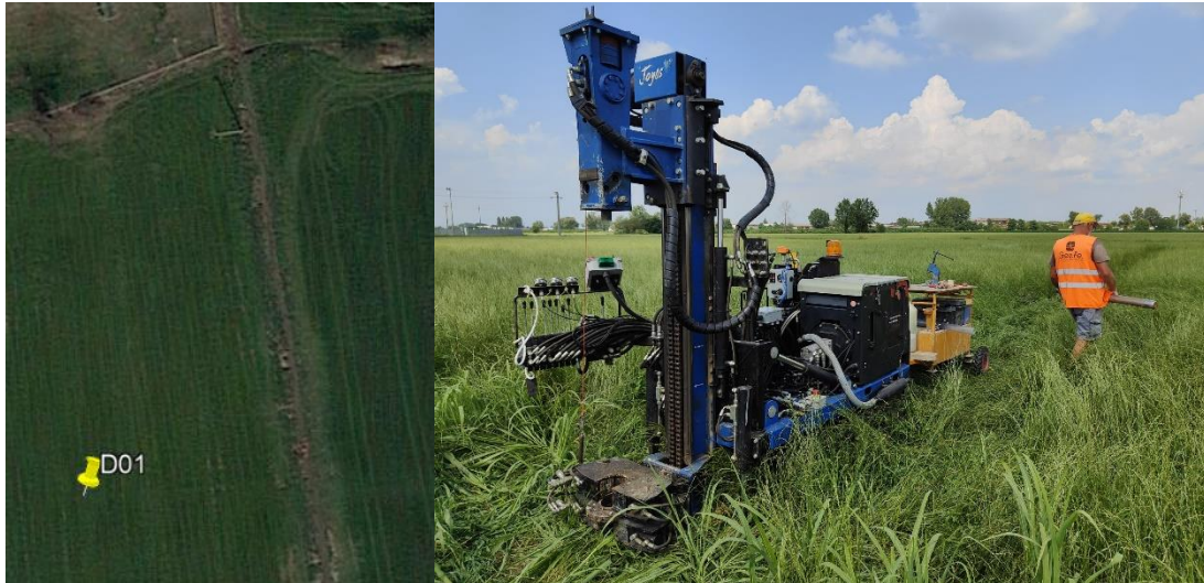
Figura 39 – ubicazione sondaggio D01 e posizionamento sonda
