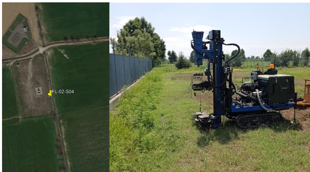
Figura 45 – ubicazione sondaggio FL02-S04 e posizionamento sonda
