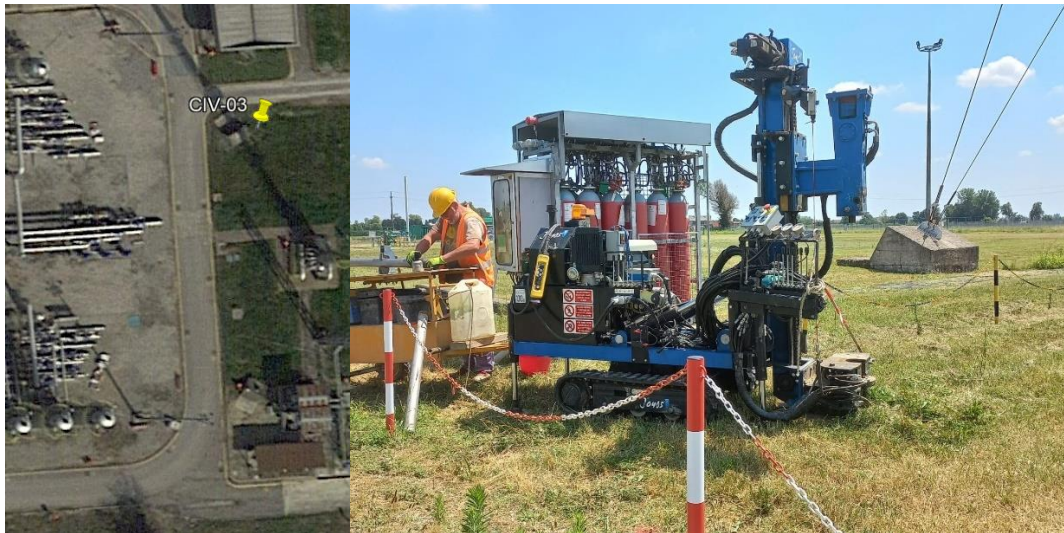
Figura 27 – ubicazione sondaggio CIV-03 e posizionamento sonda
