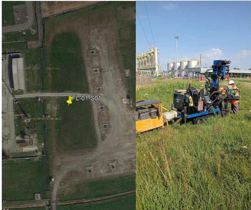
Figura 45 – ubicazione sondaggio FL01-S01 e posizionamento sonda
