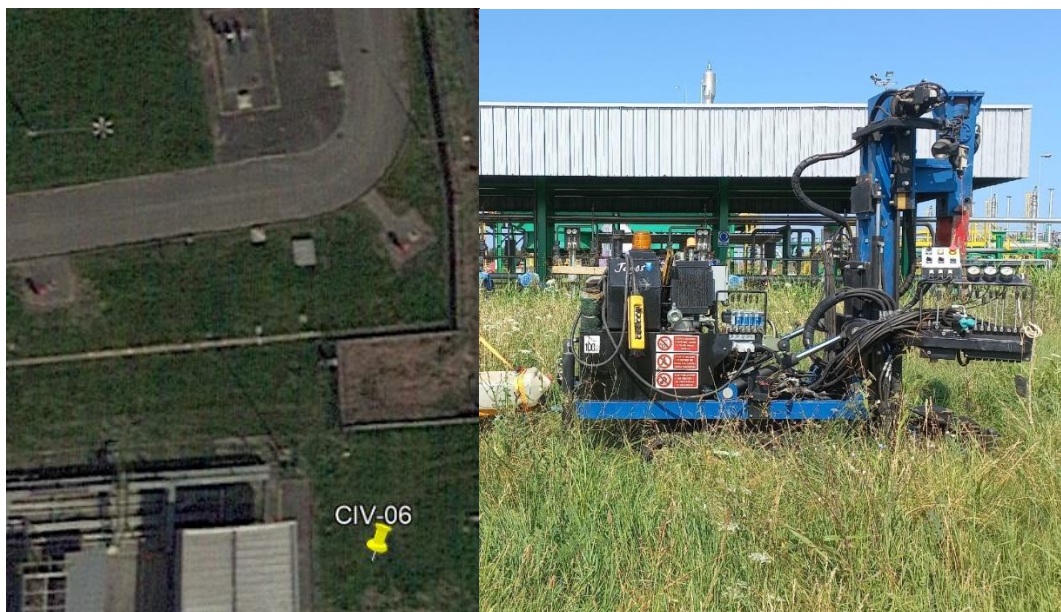
Figura 33 – ubicazione sondaggio CIV-06 e posizionamento sonda
