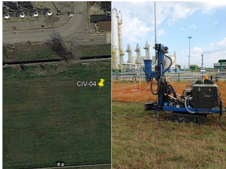
Figura 29 – ubicazione sondaggio CIV-04 e posizionamento sonda
