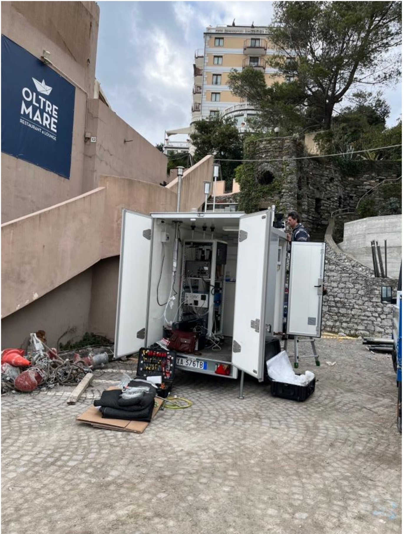
Centralina operativa dal 01/02/2023 (foto del 01/02/2023)
