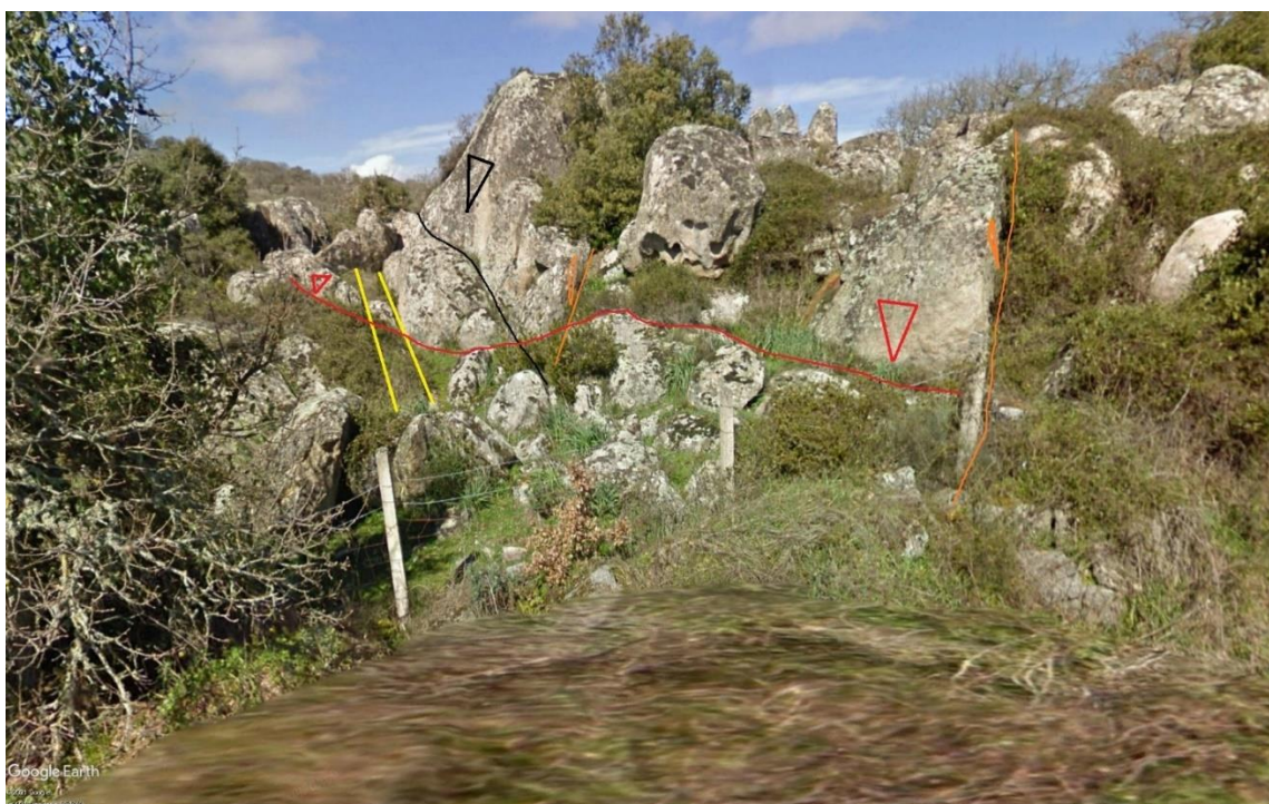
Figura 8 - Immagine di roccia in posto in cui sono evidenti le fratture dell'ammasso
