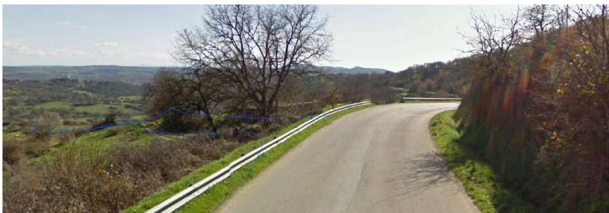
Figura 49 - Foto dalla S.P.107 in prossimità dell'accesso agli aerogeneratori B03 e B04
