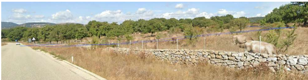
Figura 51 - Foto dalla S.P.107 in prossimità dell'accesso all'aerogeneratore B07
