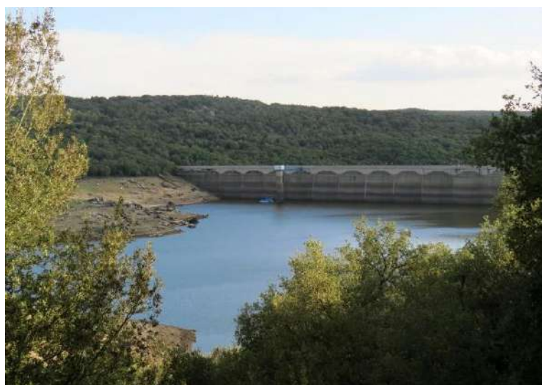
Figura 128 – Diga Sos Canales – Buddusò
