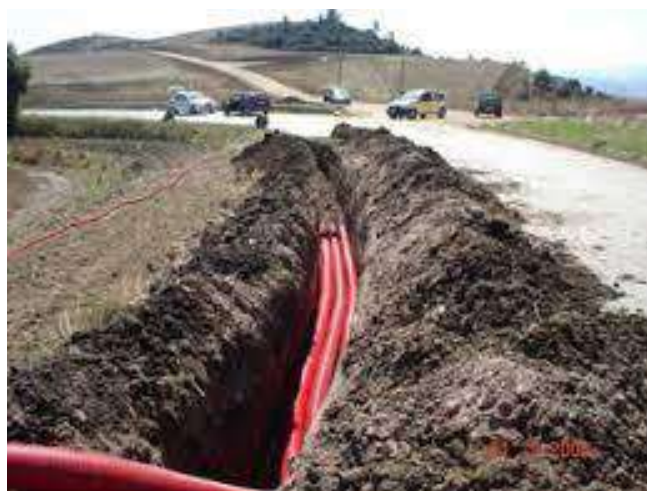
Figura 79 - Posa cavidotto MT tipo
