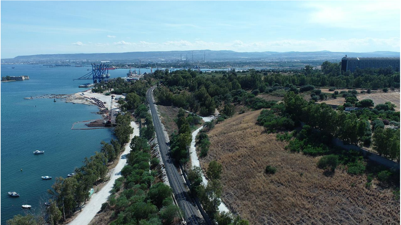
Figura 26 - Panoramica (da nord) della località Costa dei Conti verso il porto commerciale e l'Aeroporto Militare (cfr. elaborati RS6200D38N7AH0001001-3A, aree D-E-F).
