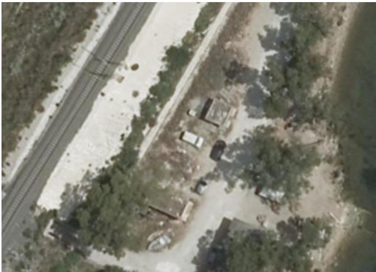
Figura 7-6 Manufatti ad uso produttivo, oggetto di demolizione
