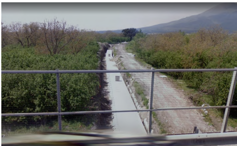
Figura 4 Intervento di manutenzione del 2007 sul canale tombato.
