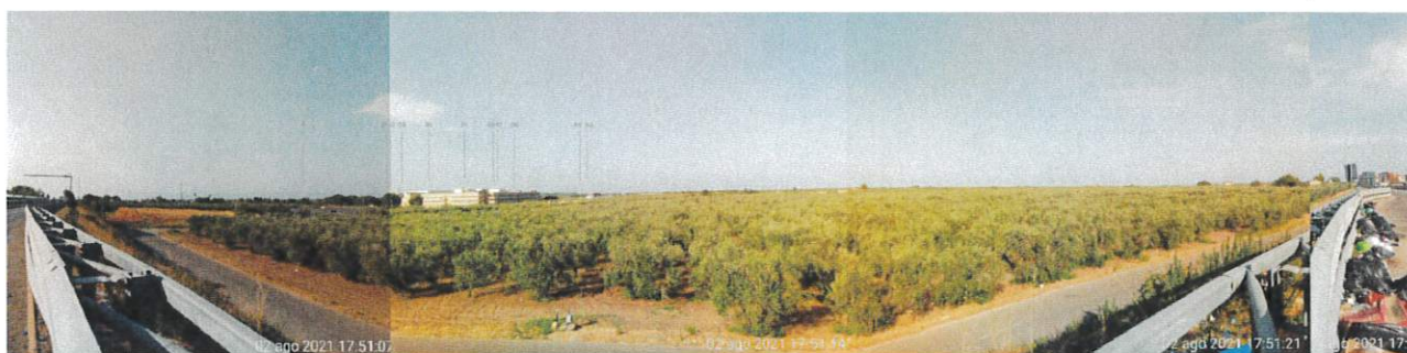
Punto di vista 1 – post operam
