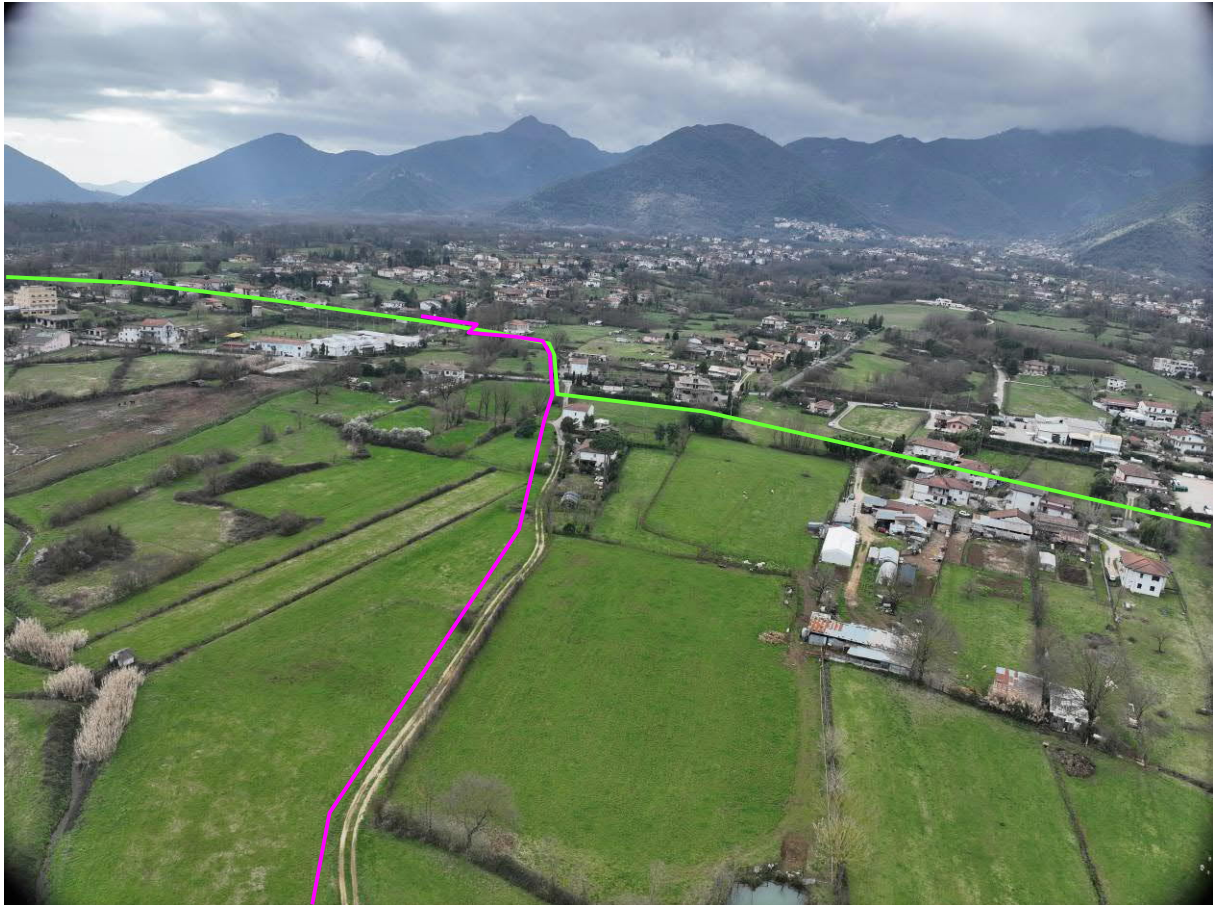
Foto 68: Metanodotto da dismettere nel Comune di Supino e Rifacimento Allaccio Comune di Supino
