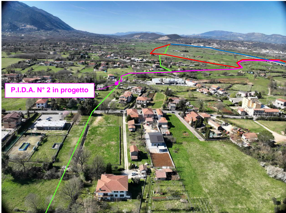
Foto 65: Metanodotto da dismettere nel Comune di Supino e Rifacimento Allaccio Comune di Supino
