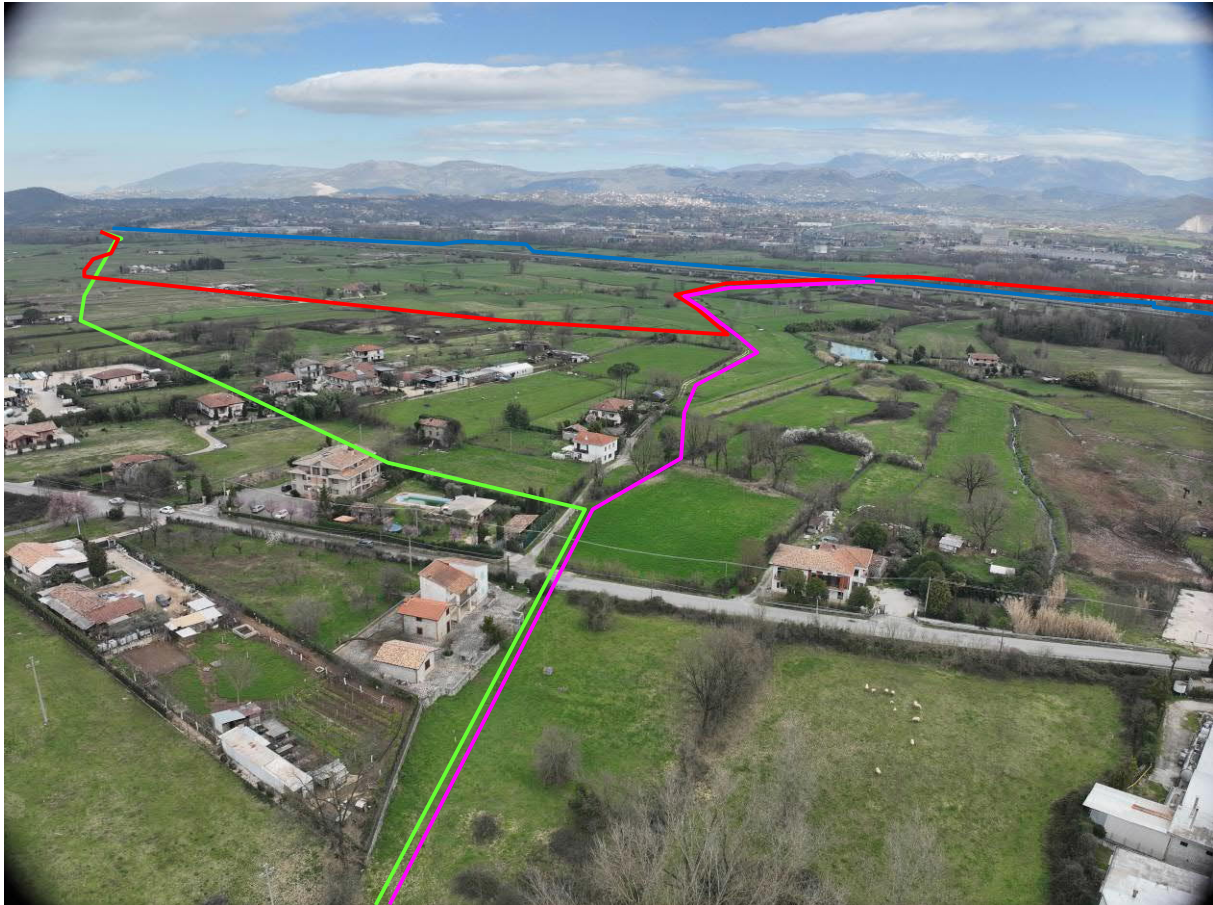
Foto 67: Metanodotto da dismettere nel Comune di Supino e Rifacimento Allaccio Comune di Supino
