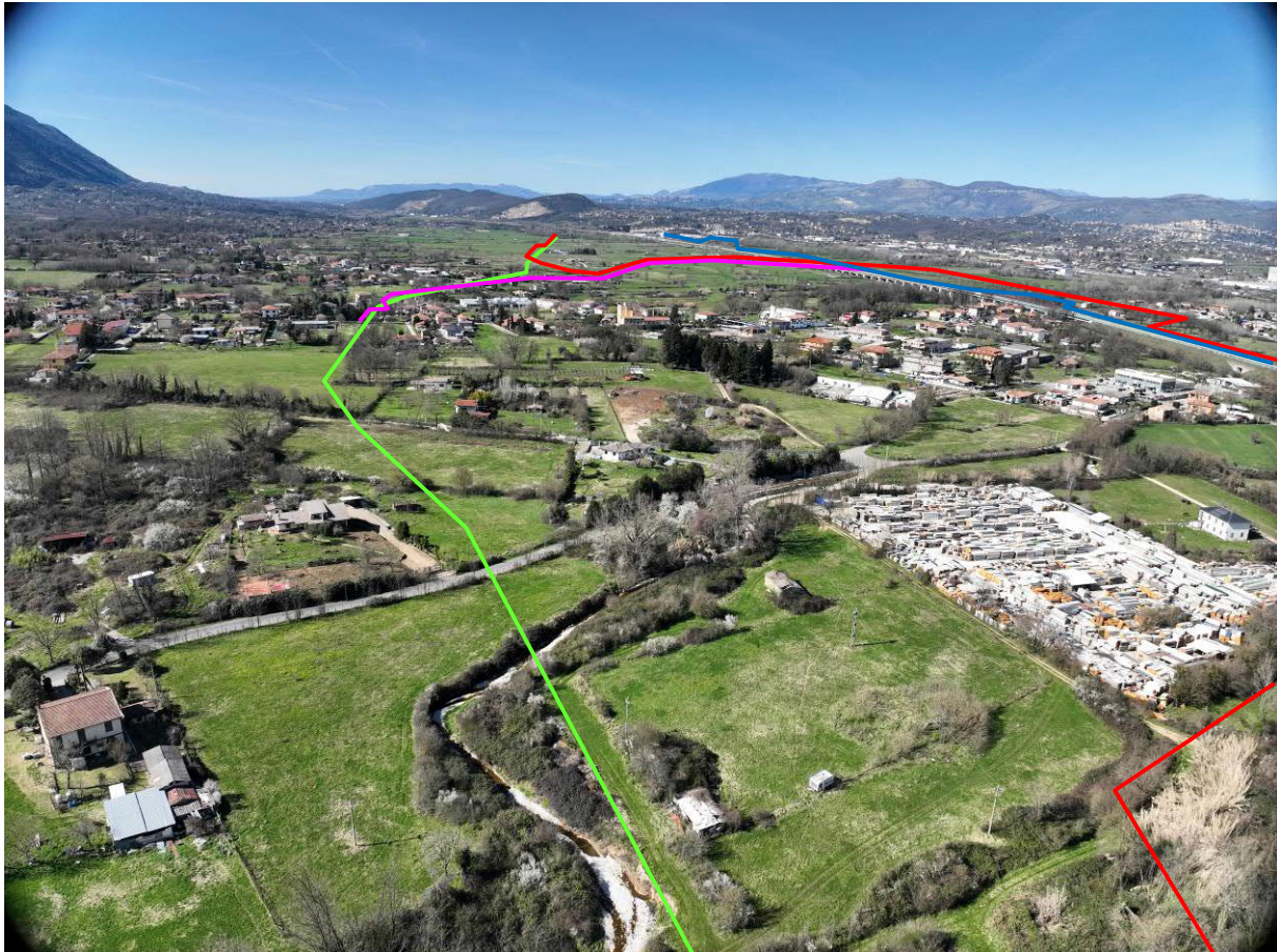
Foto 63: Metanodotto da dismettere nel Comune di Supino
