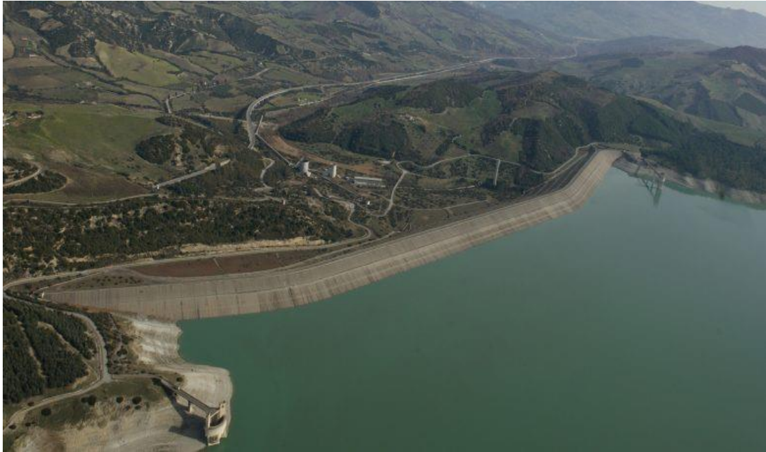
Diga di San Giuliano
