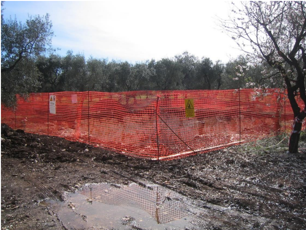
Figura 3: Area di cantiere per la piazzola sostegno
