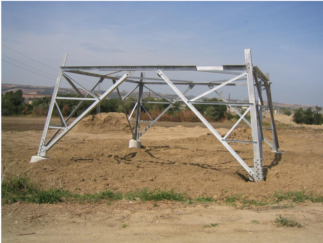
Figura 5: Base del sostegno dopo ricopertura degli scavi
