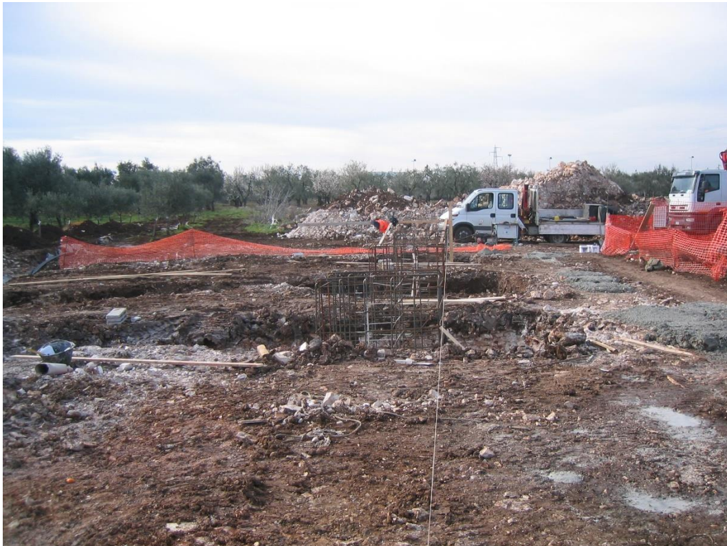
Figura 4: Buche per l'alloggiamento delle fondazioni
