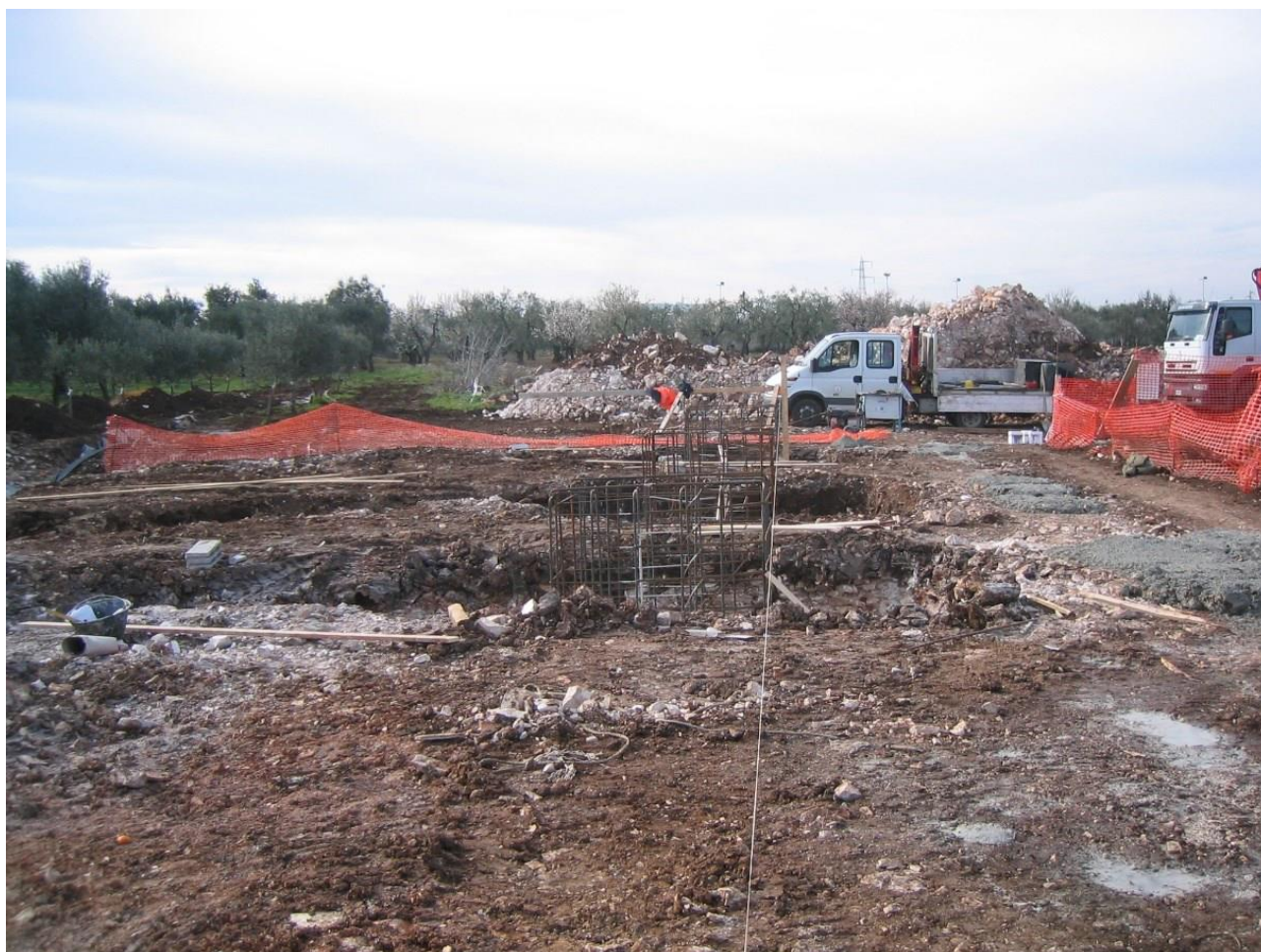
Immagine 2: Buche per l'alloggiamento delle fondazioni
