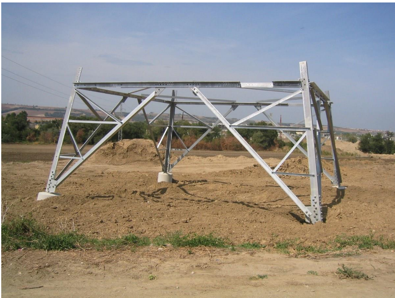
Immagine 3: Base del sostegno
