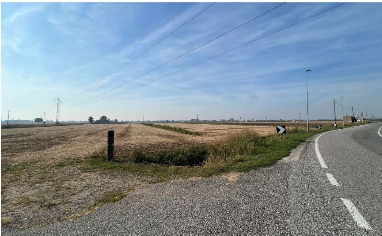
Figura 5.36 - FOTO 13 Stazione elettrica ante operam
