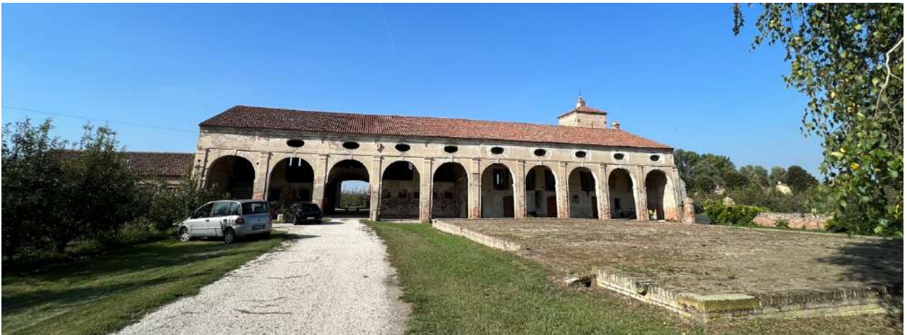
Figura 5.3 la Barchessa di villa Morosini - ingresso da Piazza Aldo Moro
