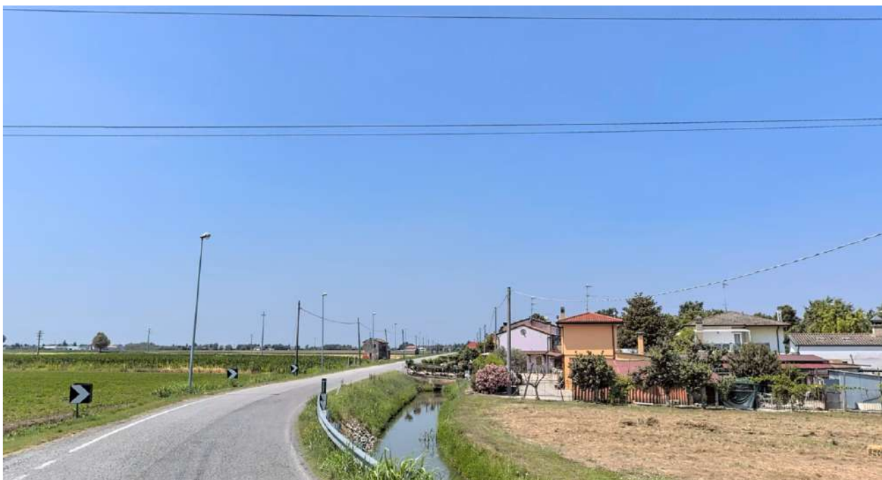
Figura 5.15 Foto dell'area limitrofa alla Stazione Elettrica
