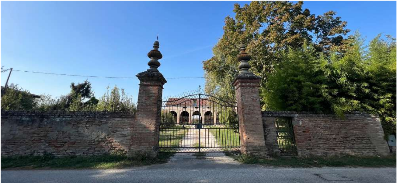
Figura 5.2 la Barchessa di villa Morosini - ingresso da Piazza Aldo Moro
