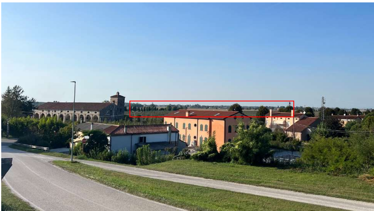
Figura 5.7 FOTO DA VIA ADIGE SUPERIORE
