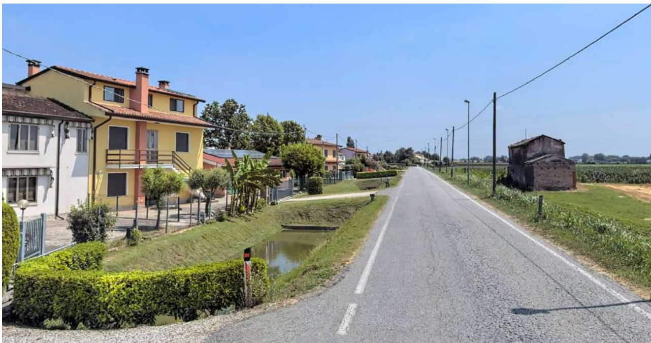
Figura 5.14 Foto dell'area limitrofa alla Stazione Elettrica
