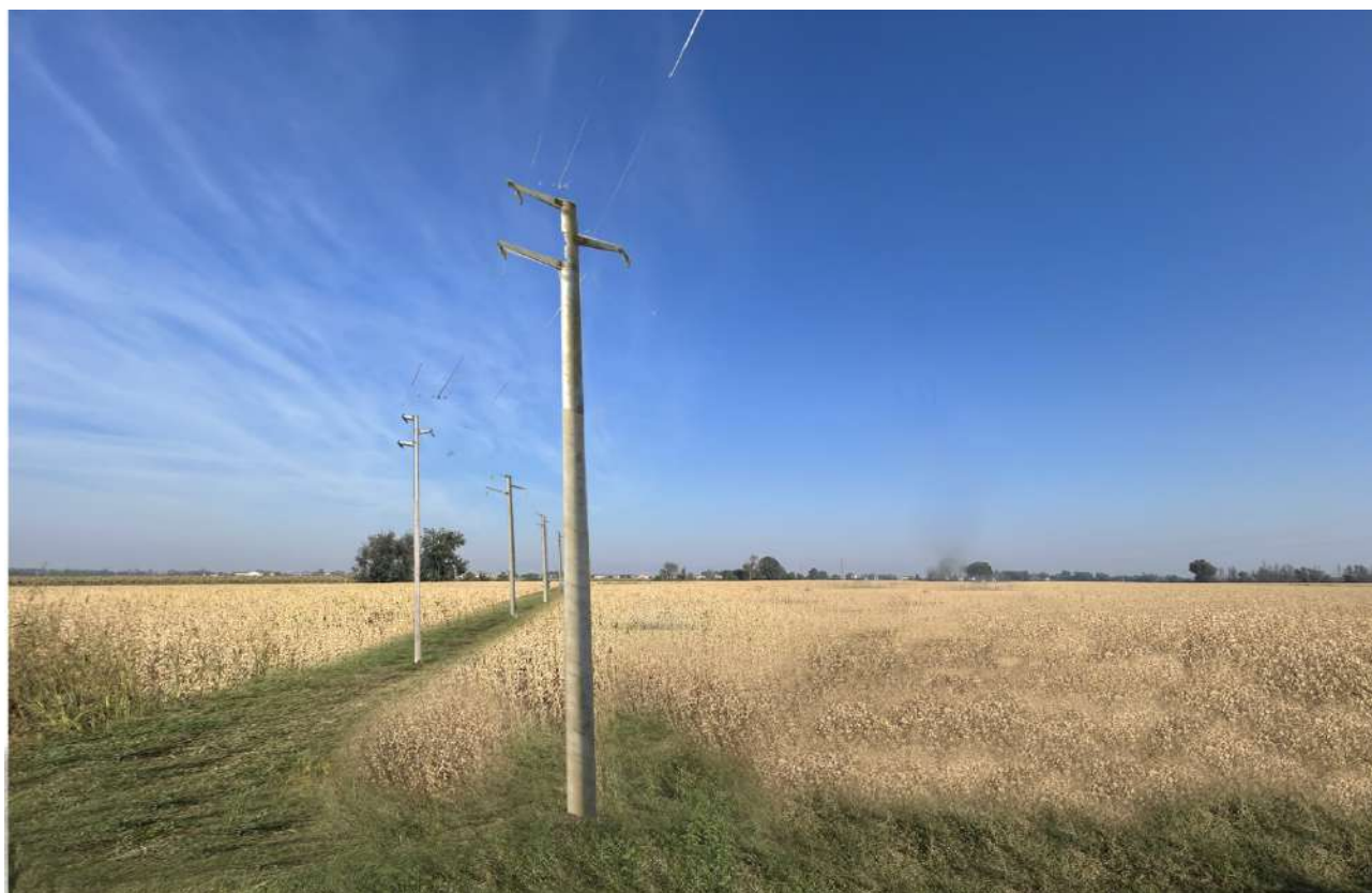
Figura 5.39 foto 14 ELETTRDOTTO DA REALIZZARE - POST OPERAM
