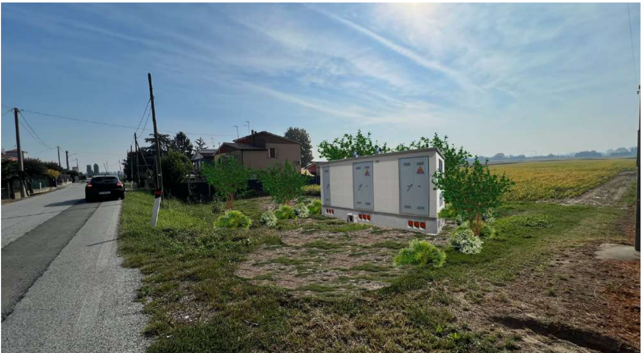
Figura 5.34 - FOTO 11 - post operam
