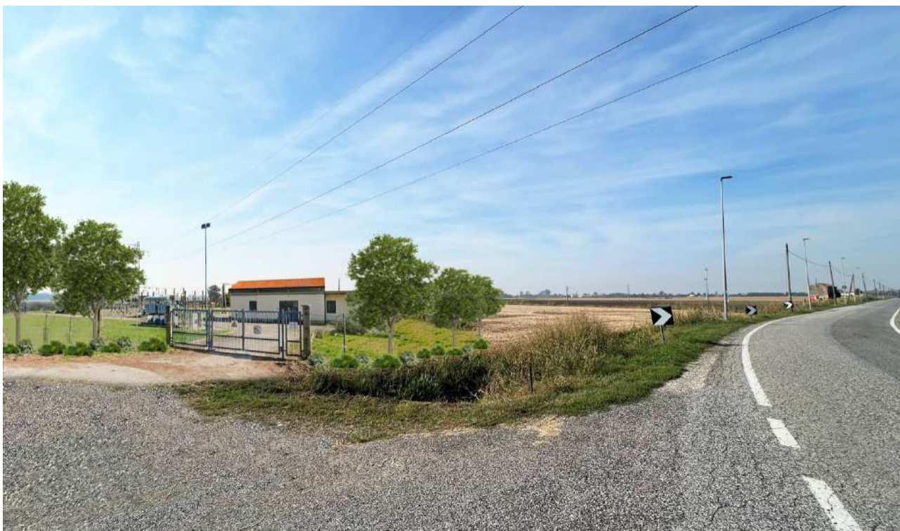
Figura 5.37 FOTO 13 Stazione elettrica post operam
