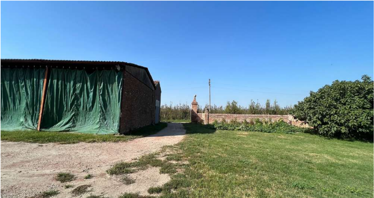
Figura 5.26 FOTO 9 (corte della Barchessa) - ANTE OPERAM
