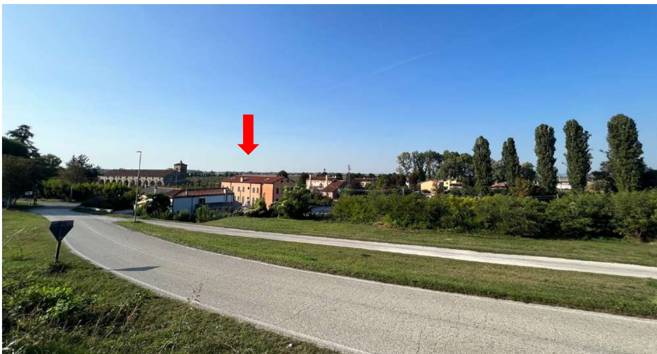
Figura 4.15 - FOTO 6 con indicazione dell'area di impianto
