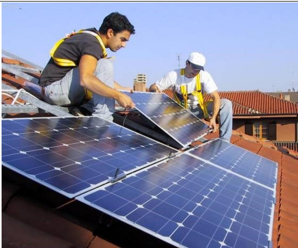
*Figura 7. Operai montatori di pannelli fotovoltaici su solai di copertura*
