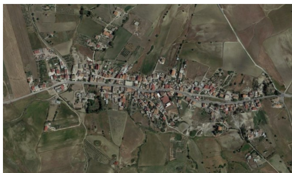
Figura 32. Foto satellitare del centro abitato Cinquegrana frazione di Castel di Judica (CT)
