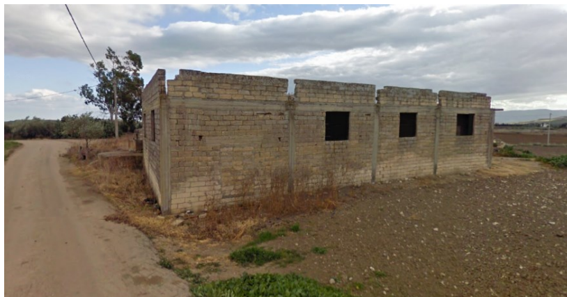
Figura 69. Foto descrittiva del B.I. Masseria Ramione nel comune di Ramacca (CT)
