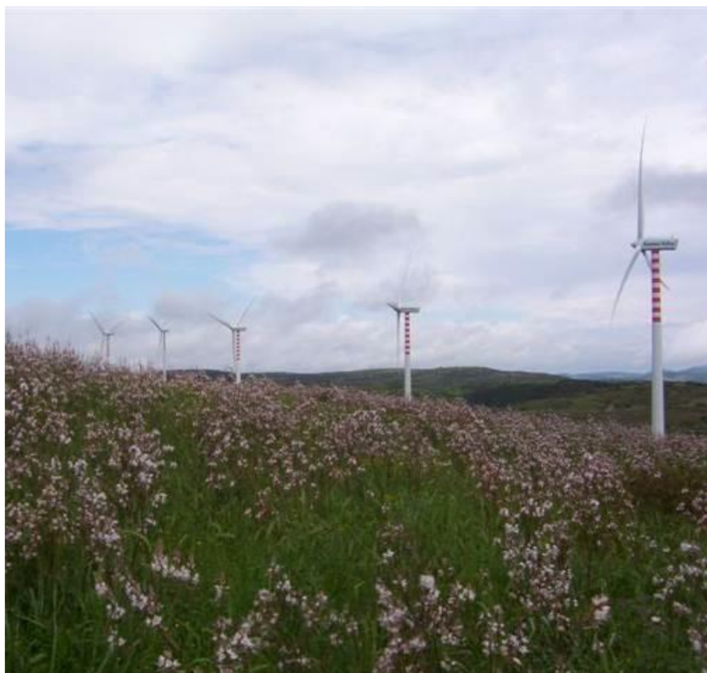
Fig. 12 Esempio di torre di sostegno tubolare
