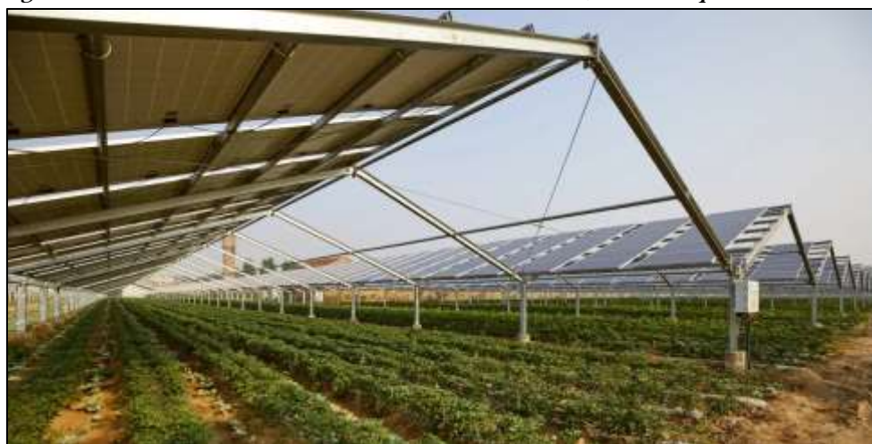
Figura 6.2. Agrovoltaico a moduli fissi con struttura a falde in Cina, in un campo coltivato a bacche di Goji
