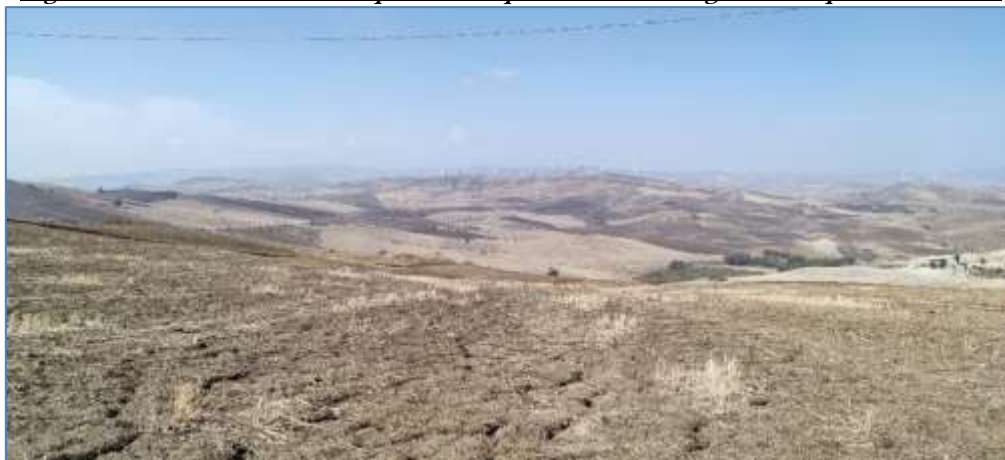
Figure 5.1-5.2. Fessurazioni superficiali tipiche dei suoli argillosi nel periodo estivo.
