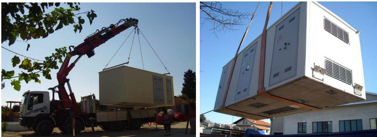
*Figura 23: Fornitura e posa in opera delle cabine di raccolta e delle Power Station*
