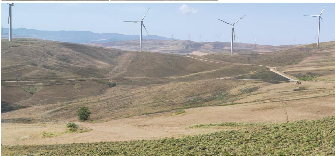
Vista in primo piano dell'impianto 3664 e dell'area non recintata e non vincolata nella disponibilità del proponente destinata a coltivazione di essenze, in particolare di vecchia. In secondo piano l'impianto 3254 con annessa area non recintata e non vincolata coltivate a sula. La fotosimulazione si riferisce ai due impianti a maturazione (3 anni di vita) e nel periodo di giugno quando le rispettive coltivazioni sono in fiore. Si rilevano all'interno dell'immagine anche l'impianto eolico esistente e i tralicci della linea di connessione dell'impianto 1007.
