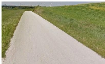
**TIPOLOGIA 1.2: Viabilità esistente in conglomerato bituminoso in pessimo stato**
