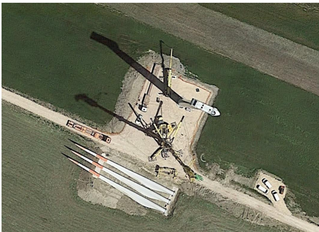
Figura 2.6 – esempio di piazzola in fase di costruzione
