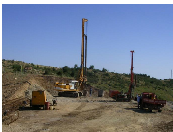
Realizzazione pali trivellati
