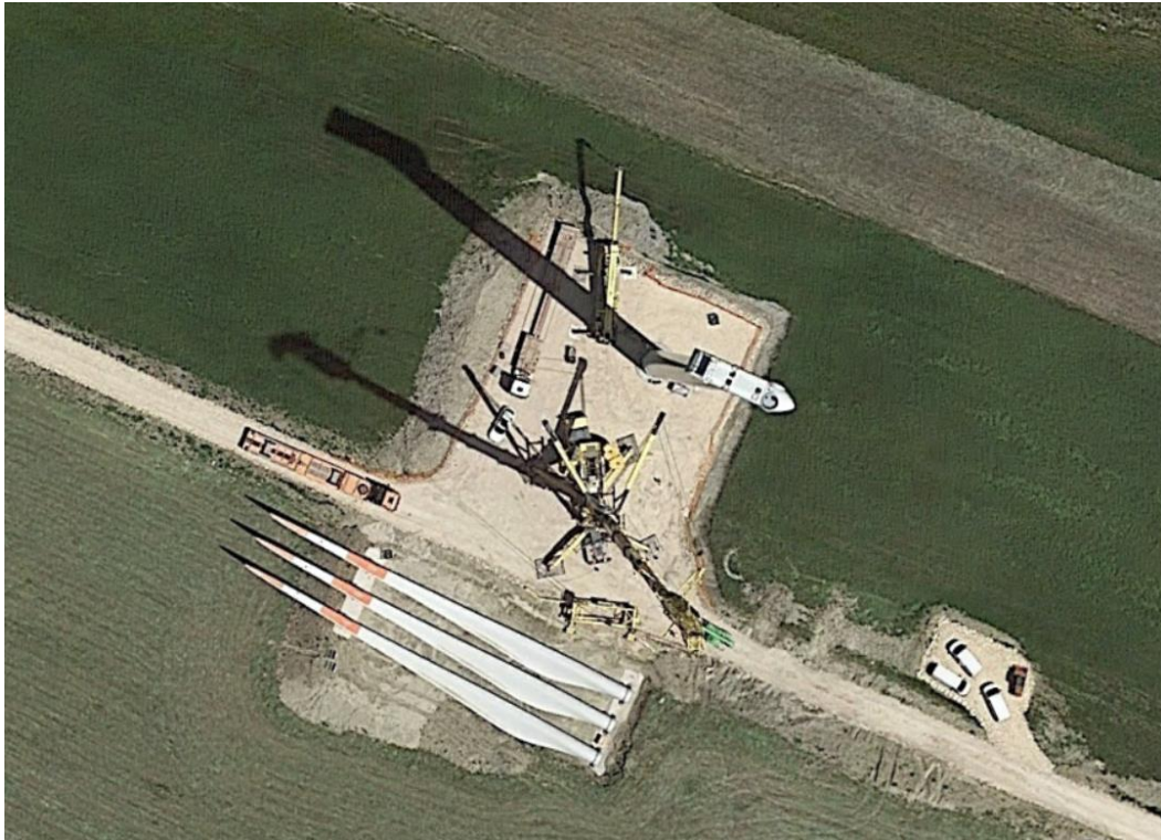
Figura 2.4 – esempio di piazzola in fase di costruzione
